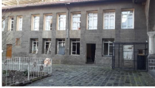
Fot. 16. Konağın doğu cephesinden görünüm (Çalın, 2015).
