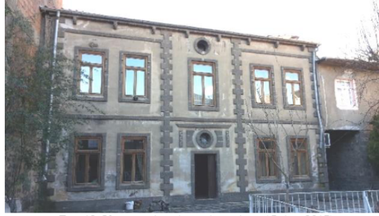
Fot. 12. Konağın batı kanadı cephesi (Çalın, 2015)
