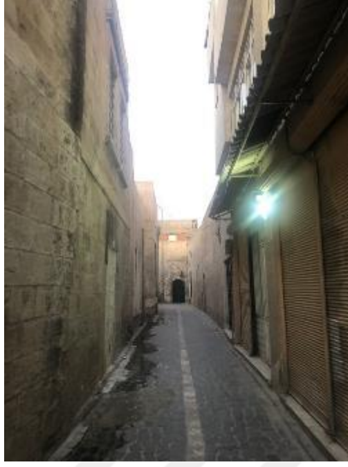
Şekil 4.63: 11 Nisan Kurtuluş İlkokulu bahçe duvarları
