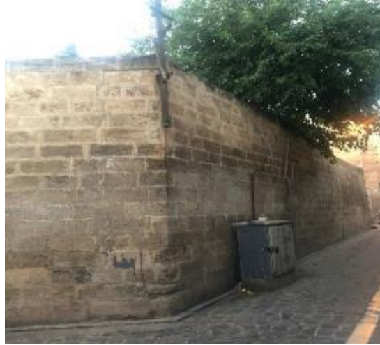
Şekil 4.62: 11 Nisan Kurtuluş İlkokulu bahçe duvarları
