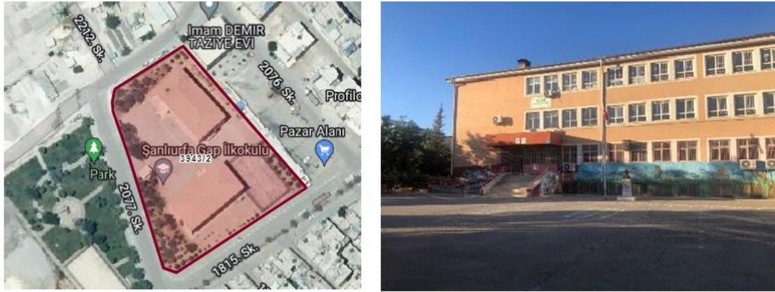
Şekil 4.50: GAP İlkokulu bahçe açık alanı genel görünüm
