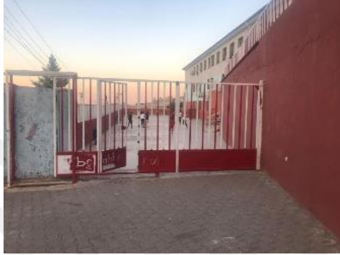
Şekil 4.67: Eyyübiye İlkokulu'nun giriş kapısı
