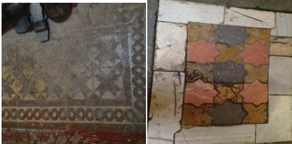
Şekil 39. Lala Mustafa Paşa Hamamı, zemin döşemesi (2017)
