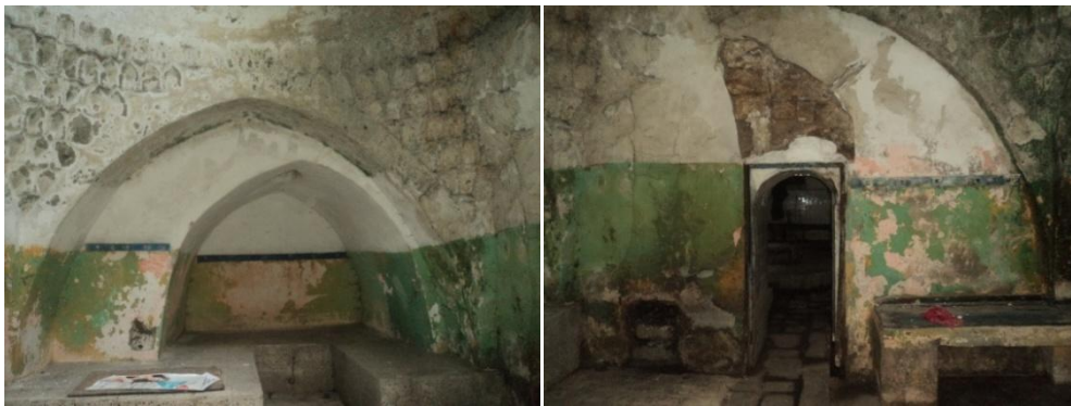
Şekil 107. Eski Hamam, ılık bölümü (2016)
