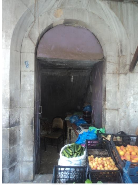
Şekil 111. Eski Hamam, erkekler bölümü giriş kapısı görüntüsü (2016)
