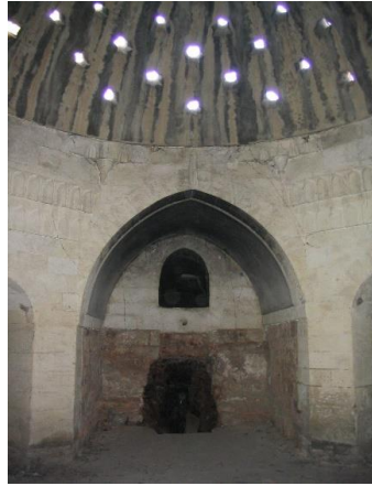
Şekil 4.5 - Sıcaklık Duvarındaki Sıcak Su Kazanına Açılan Pencere.
