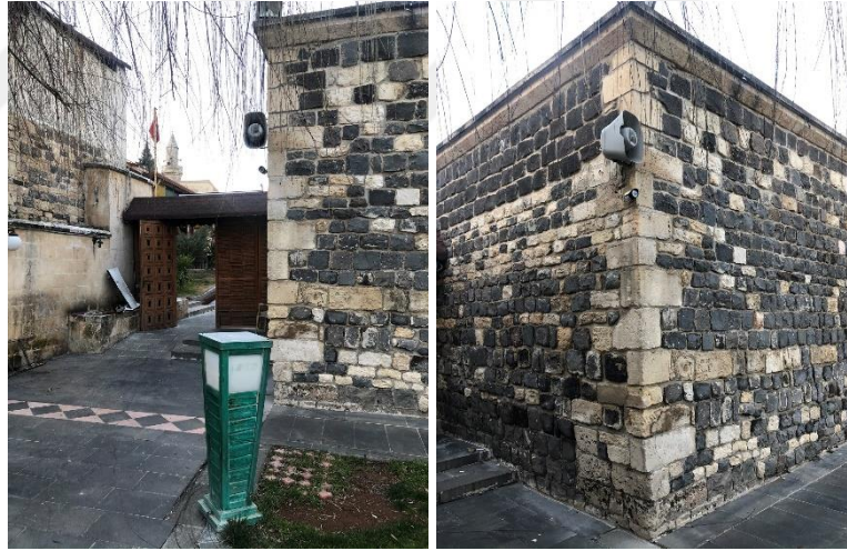
Şekil 4.17 - Güney Cephe, Yeni Ahşap Kapı (2020)
