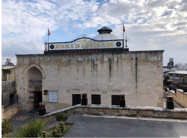
Şekil 4.10 - Kuzey Cephесinin Görünümü (2020)
