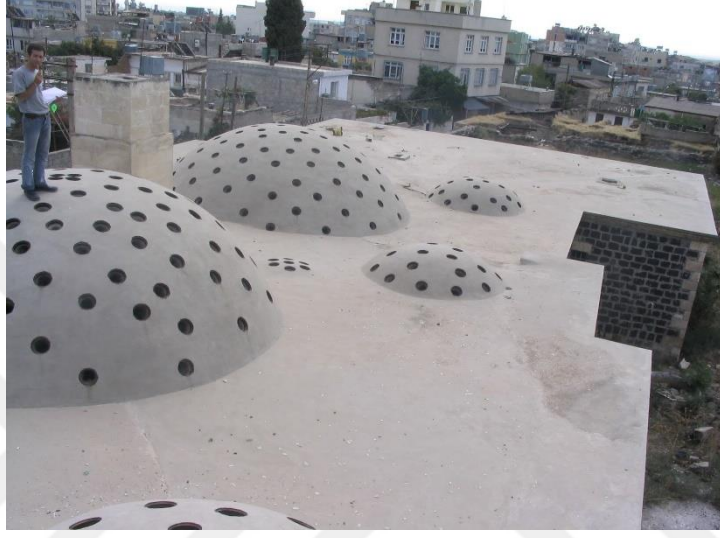
Şekil 4.7 - Ilıklık ve Sıcaklık Bölümleri Üzerindeki Çatı Örtüsü (Bebekoğlu Arşivi, 2005)
