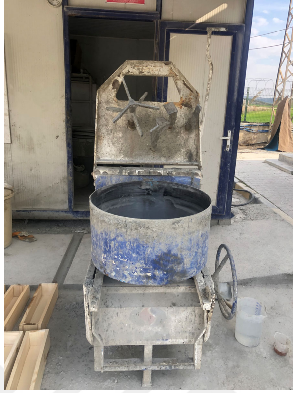
Şekil 3.3. Beton karışımı yapılan mikser.
