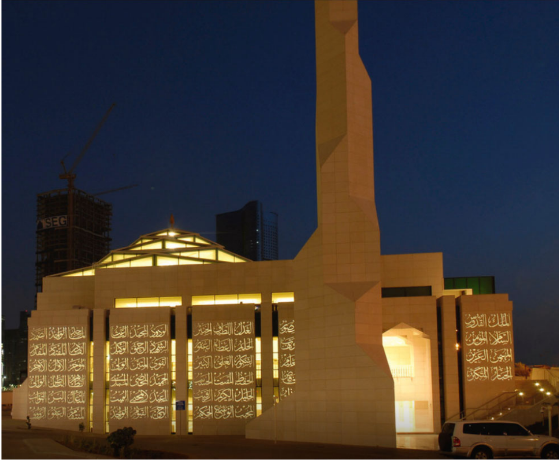
Şekil 2.6. Işık geçiren beton ile dış cephe yapımı gerçekleştirilen Al Aziz Camii – Abu Dabi – Birleşik Arap Emirlikleri (URL-4)
