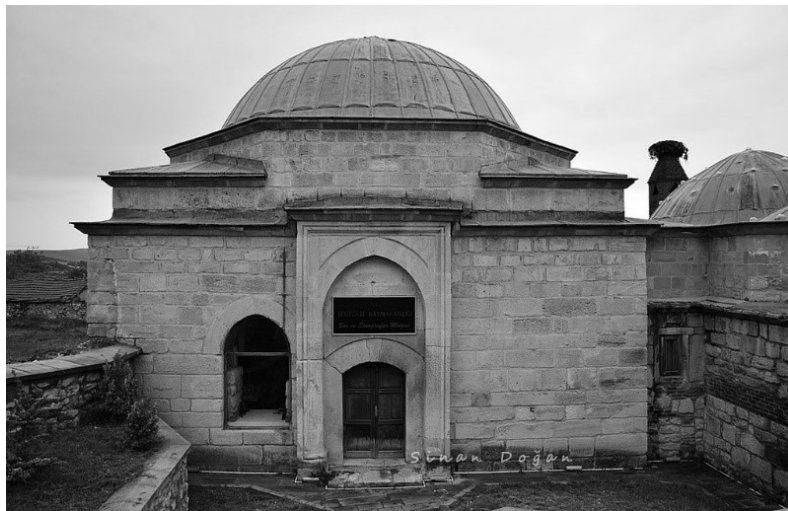
Şekil 2.33. Hamam yapıları, Selçuklu Hamamı [Url-5]
