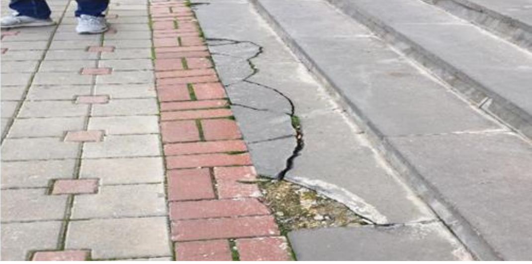
Şekil 2.3. Bahçede Oluşan Kırık Kaldırım Taşlarının Onarımı
