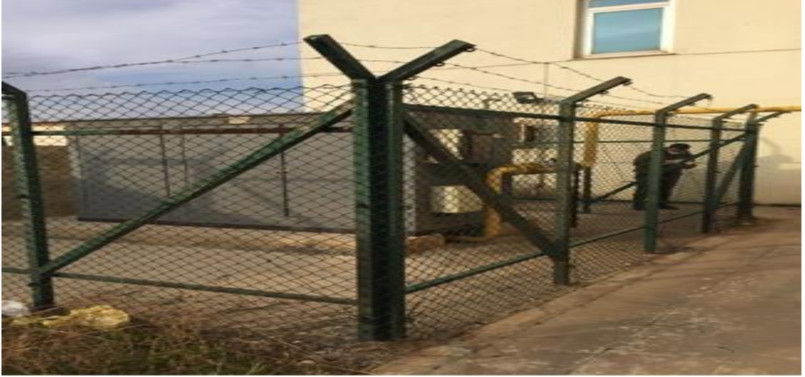
Şekil 2.7. Gazdaş Santralının Dört Yanına Uyarı Levhası Asılması
