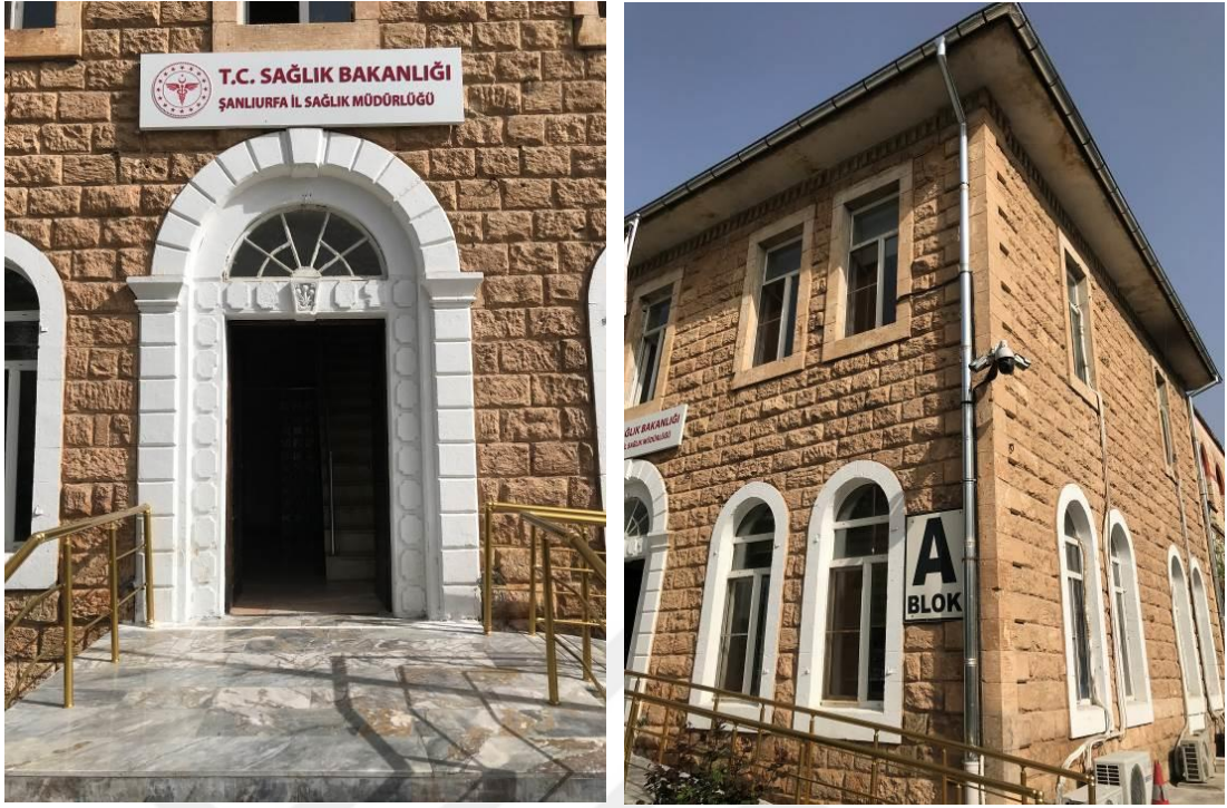
Şekil 3. 83. a) Güney Cephede Yer Alan Giriş Kapısı, b) Güneydoğu Cephe Köşe Bordür ve Cephe Elemanları
