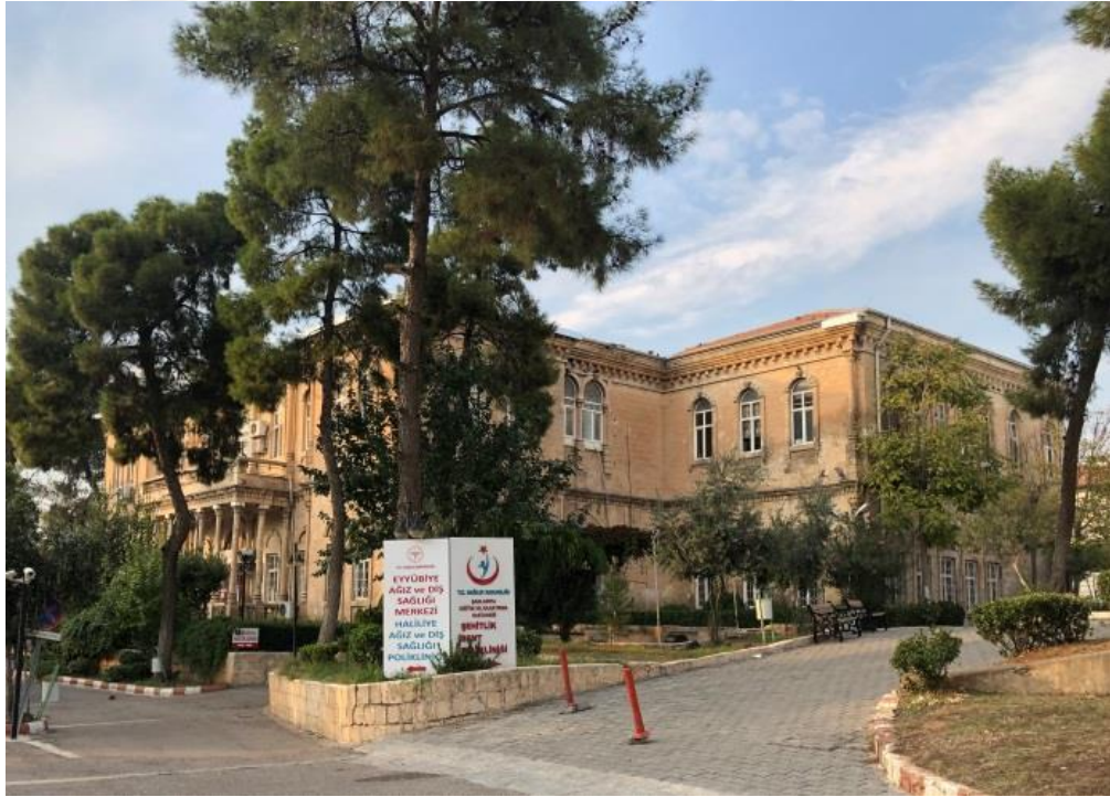
Şekil 3. 64. Millet Hastanesi Güneydoğu Cephe Görünümü (2020)
