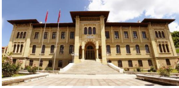
Şekil 2. 46. Kastamonu Hükümet Konağı Ana Giriş Cephesi Günümüz Görünümü (Url-37)
