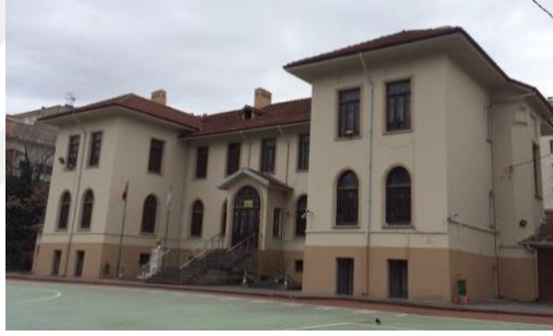
Şekil 2. 52. Mimar Kemal İlkokulu Ana Giriş Cephesi Günümüz Görünümü (Url-40)
