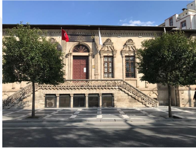
Şekil 3. 27. Ana Giriş Merdivenlerine Bakış (2020)
