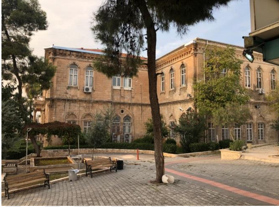
Şekil 3. 65. Millet Hastanesi Doğu Cephe Görünümü (2020)
