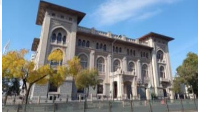
Şekil 2. 54. Ziraat Bankası Genel Müdürlük Binası Ana Giriş Cephesi Günümüz Görünümü (Url-41)
