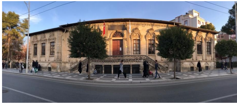
Şekil 3. 24. Köy Yatı Mektebi Binası Batı Cephesi Görünümü (2020)
