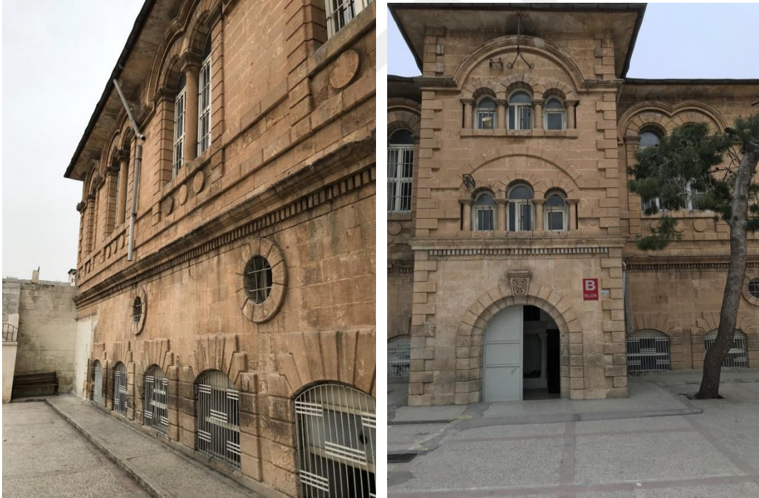
Şekil 3. 13. a) Batı Cephesi Kuzey Bölümüne Bakış, b) Batı Cephesi Ana Portal Görünümü (2020)
