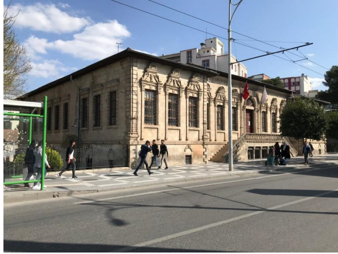
Şekil 3. 26. K y Yatı Mektebi Binası Kuzeybatı Cephe G r n m  (2020)
