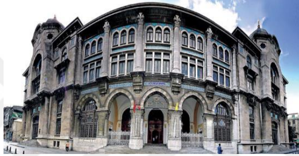
Şekil 2. 48. Büyük Postane Ana Giriş Cephesi Günümüz Görünümü (Url-38)
