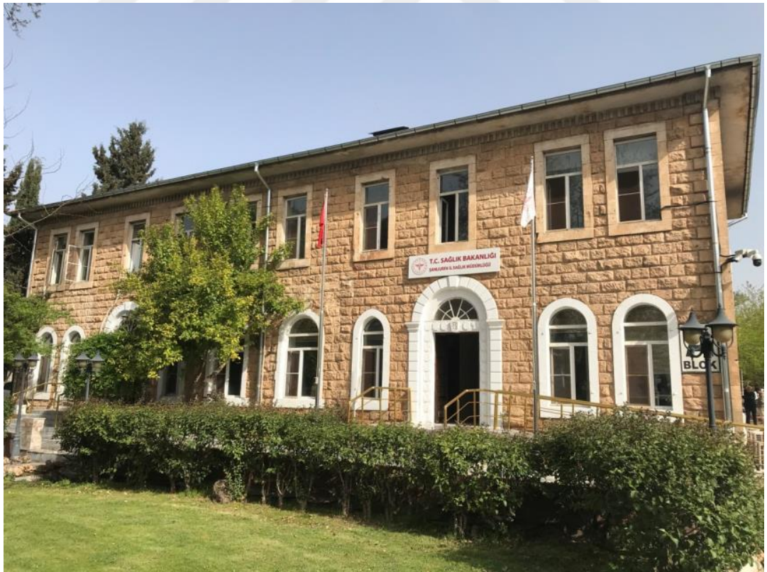
Şekil 3. 84. Ermeni Yetimhanesi Güney Cephe Görünümü
