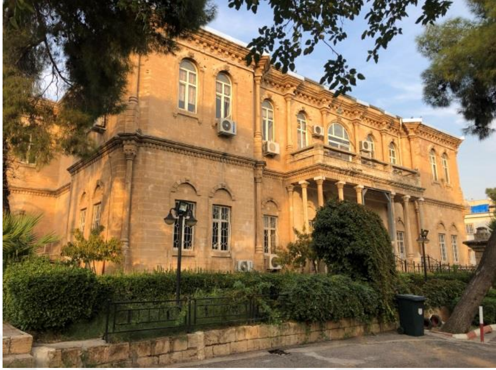
Şekil 3. 63. Millet Hastanesi Güney Cephe Görünümü (2020)
