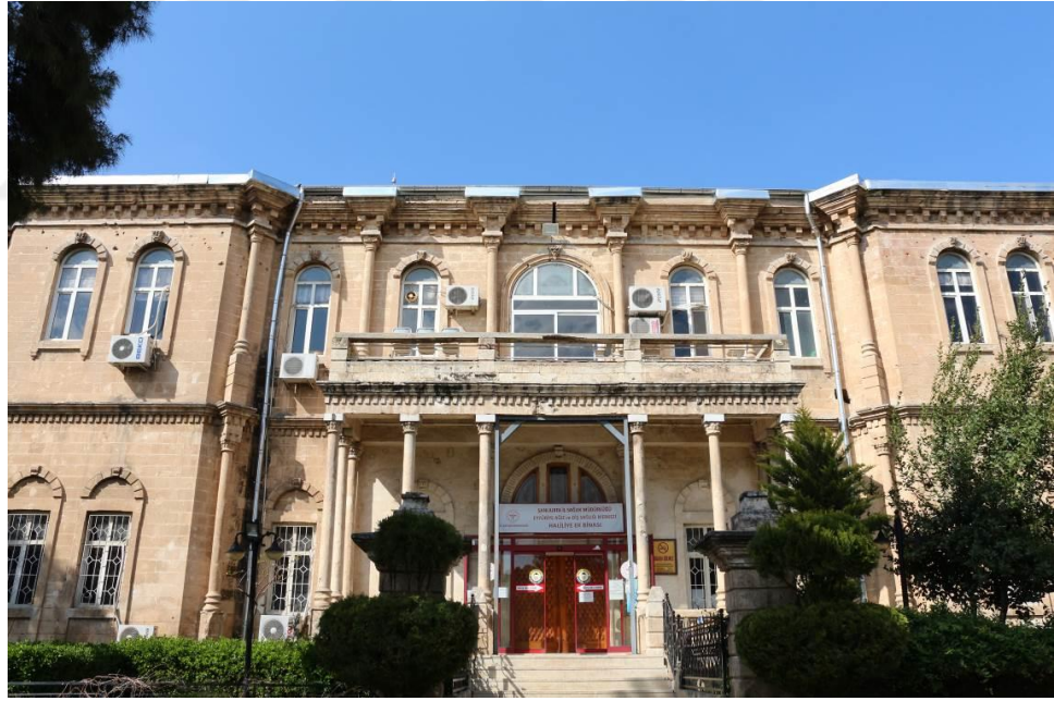
Şekil 3. 66. Millet Hastanesi Güney Cephede Yer Alan Ana Giriş Saçığına Bakış (2021)
