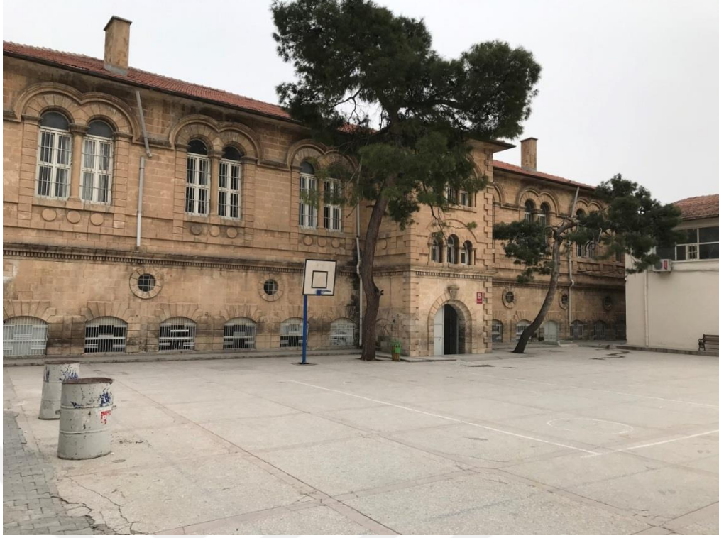
Şekil 3. 12. Basmahane Batı Cephesi Görünümü (2020)
