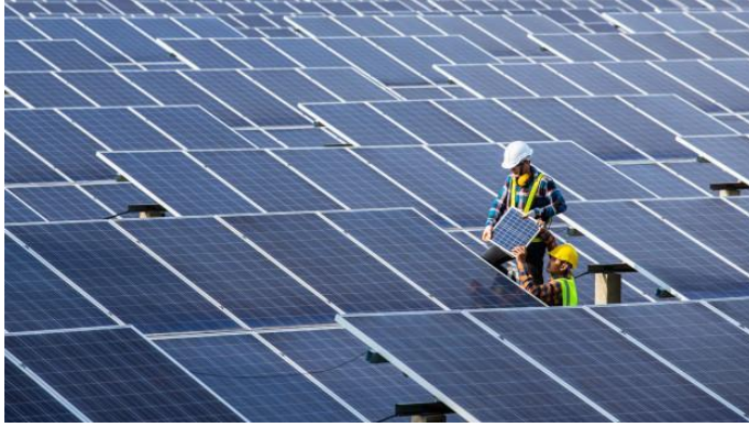
Şekil 2. Güneş paneli görüntüsü
