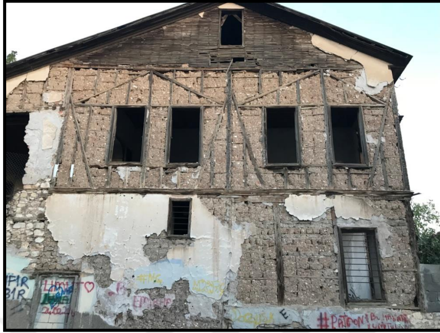
Şekil 2.19: Çelebiler Konağı ahşap çerçevesi kerpiç dolgulu dış duvarı (Aytemiz,2020)
