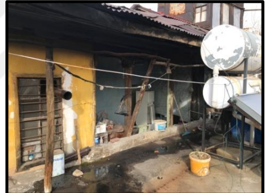
Şekil 3.19: Bitişik betonarme binadan sofaya bakış (Aytemiz,2020)
