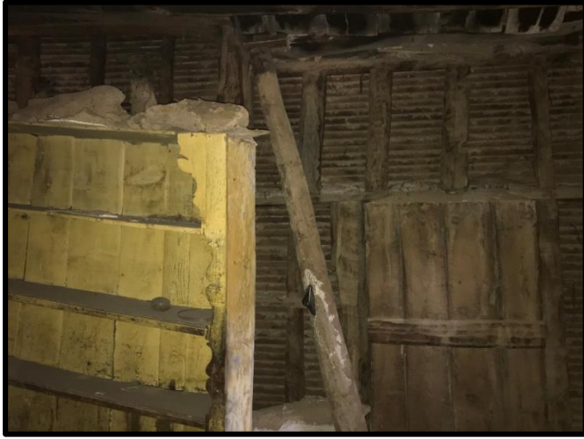
Şekil 3.22: Mutfak bağdadi sıvalı duvar (Aytemiz,2020)
