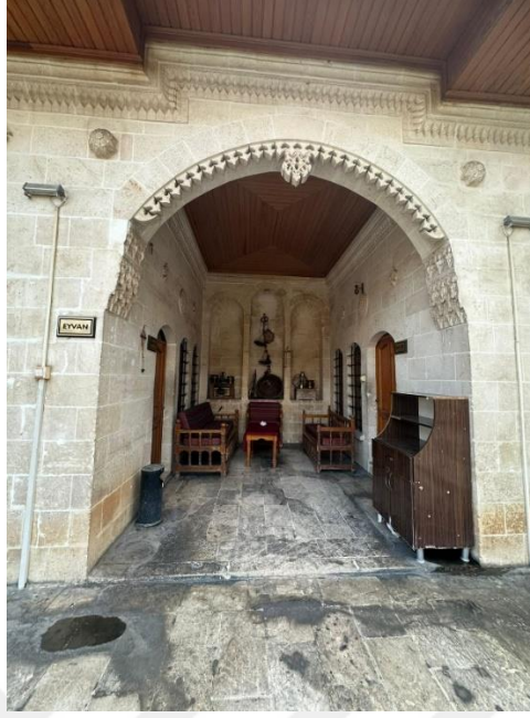
Şekil 4.4. Çubukçular Evi Eyvanı
