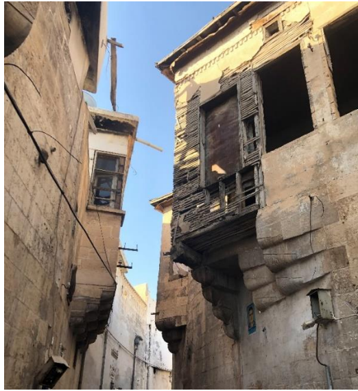
Şekil 4.19. Zincirli Sokak'tan çardak görünümü
