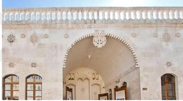
Şekil 4.37. Hacıbanlar evi Haremlik bölümü Avlusu bezemeleleri
