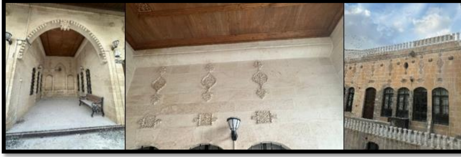
Şekil 4.43 (b) Şahap Bakır Evi haremlik bölümünün avlu bezemeleri
