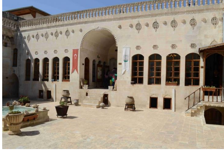
Şekil 4.35. Hacıbanlar Evi Haremlik bölümü Avlusu
