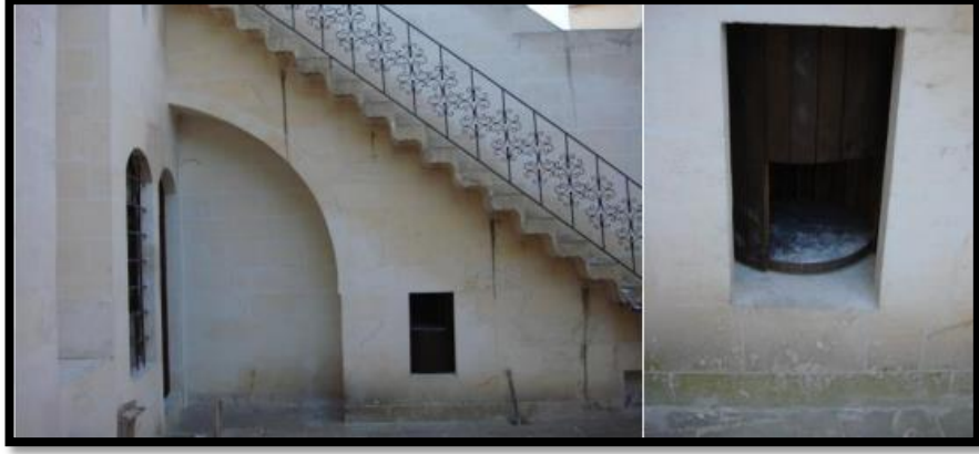
Şekil 4.18. Buluntu Hoca Evi Döner Dolap (Açanal,2015)
