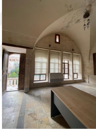
Şekil 4.40 (b) Şahap Bakır evi oda pencerelerinin iç görünüşleri
