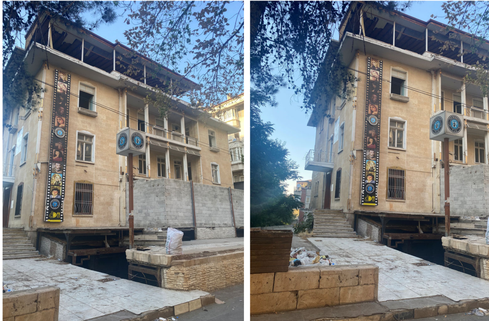
Şekil 4.12. Ömer Ersoy Apartmanı Günümüz Görselleri, 2023
