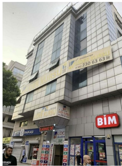
Şekil 4.18. Cemil Alevli Apartmanının Yerine Yapılan Yapı, 2023
