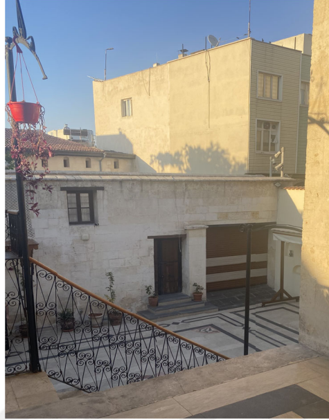
Şekil 2.7. Geleneksel Gaziantep Evi Avlu Örneği, Suyabatmaz Mahallesi, 2023
