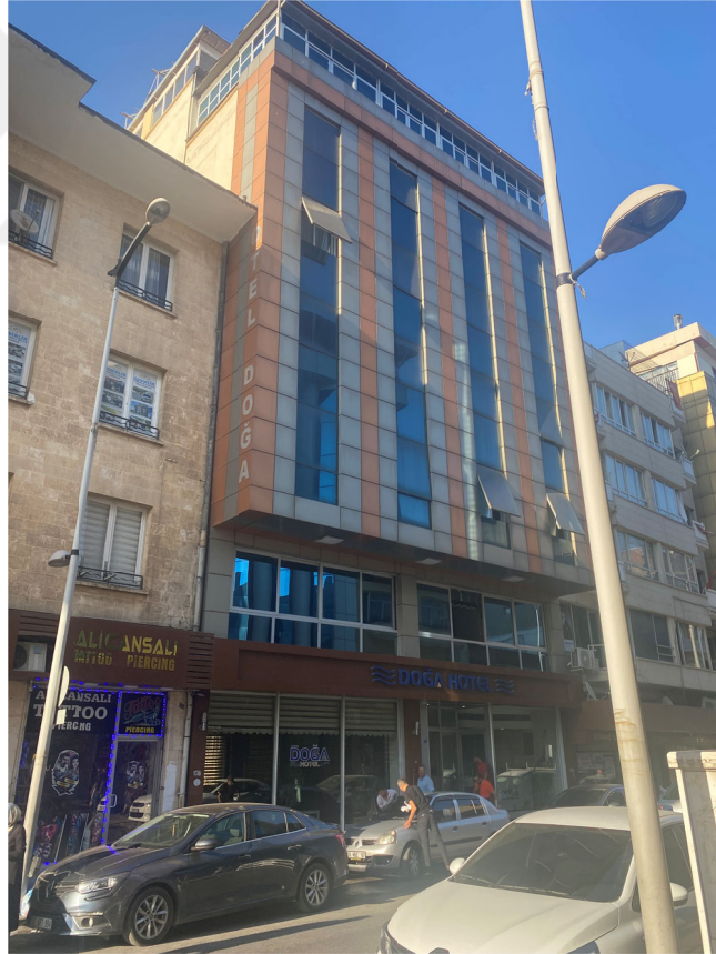
Şekil 4.15. Mahmut Ersoy Apartmanı yerine yapılan yapı, 2023
