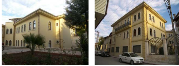
Fot. 17. Poliklinik A Blok binası (Uğraş, 2005).
