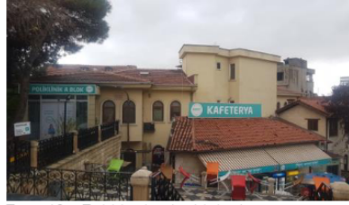
Fot. 18. Poliklinik A blok binası ve kafeterya (Aygün, 2018).
