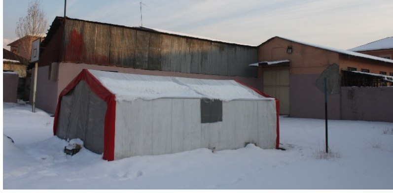
Şekil 6.23: Metal Atölyesi Kuzeydoğu Yönü (Van Kudeb,2018).
