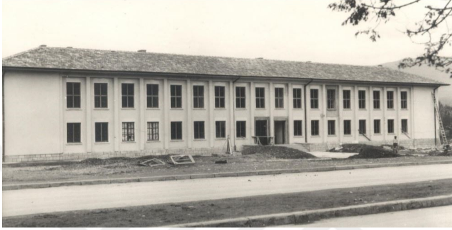
Şekil 5.59: Tokat Erkek Sanat Enstitüsü Ana Bina İnşaatı-1958 (URL 15).
