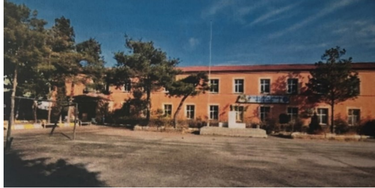
Şekil 6.12: Van Erkek Sanat Enstitüsü Ana Bina (Van Kudeb,2018).
