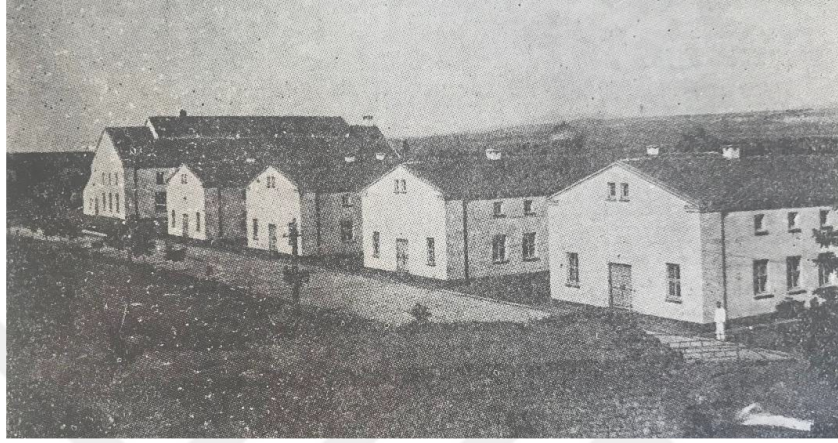
Şekil 5.14: Kayseri Erkek Sanat Enstitüsü (Oran,1952).
