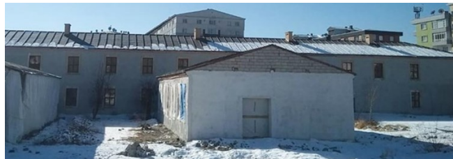
Şekil 6.46: Binanın Kuzey Cephesi Yarım Kalmış Hali (Yıldız, 2020)
