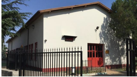
Şekil 5.26: Bursa Erkek Sanat Enstitüsü güneydoğu ve güneybatı cephesi makine atölyesi (Durmuş, 2016).
