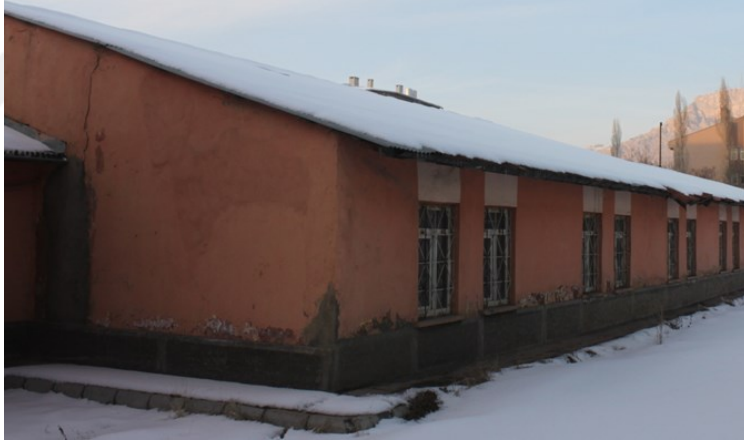
Şekil 6.22: Metal Atölyesi Doğu Koridoru (Van Kudeb,2018).
