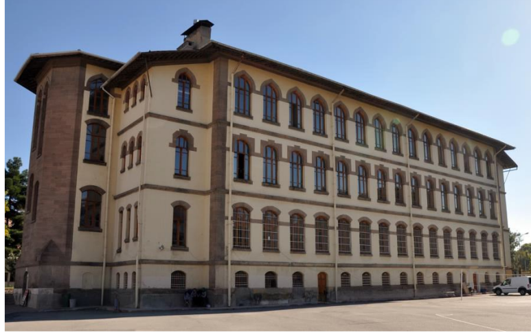
Şekil 4.29: Konya Lisesi Arka Cephe (Öner 2016).
