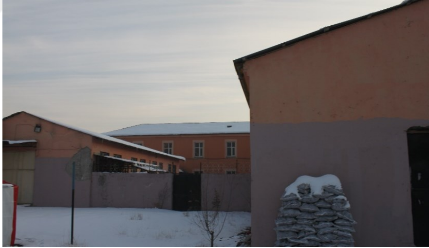
Şekil 6.26: Metal Atölyesi-Tevsiye Atölyesi arasındaki avlu giriş kapısı (Van Kudeb,2018).
