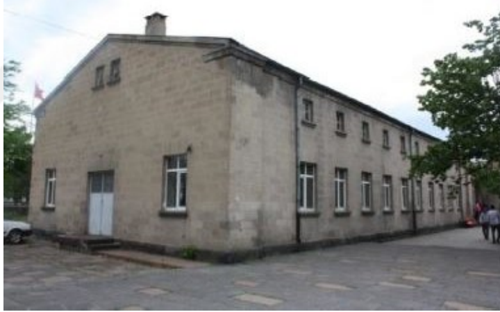
Şekil 5.17 Kayseri Erkek Sanat Enstitüsü Tevsiye Atölyesi Ön Cephe (Işık, 2010).
