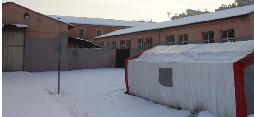
Şekil 6.24: Tevsiye Atölyesi Kuzeydoğu Yönü (Van Kudeb,2018).
