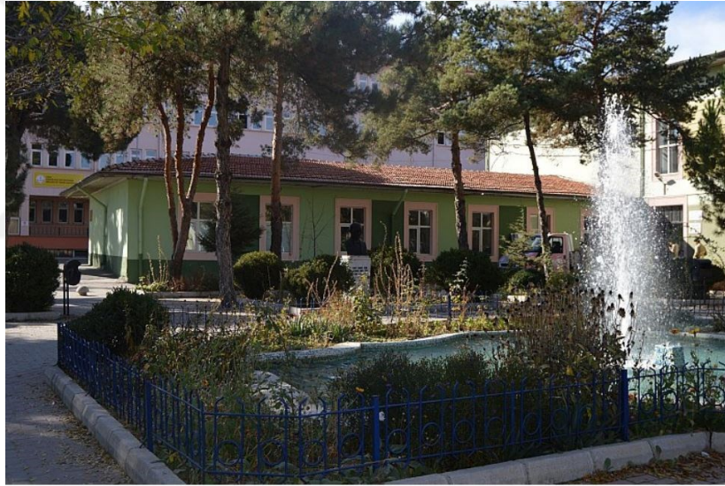
Şekil 5.48: Uşak Erkek Sanat Enstitüsü İdare Bloğu (URL 13)
