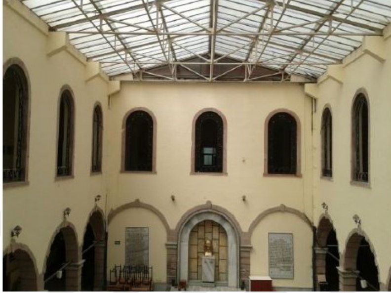
řekil 4.3: İzmir Mithat Pařa Anadolu Teknik Ve Endstri Meslek Lisesi Avluyu rten atı (Kaptan, 2018)
