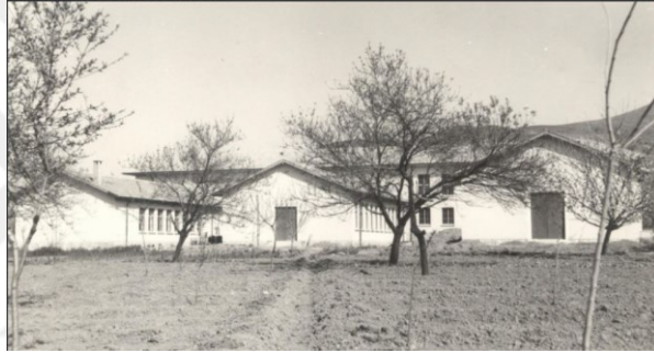
Şekil 5.62: Tokat Erkek Sanat Enstitüsü Atölye Bahçe Cephesi (URL 15)
