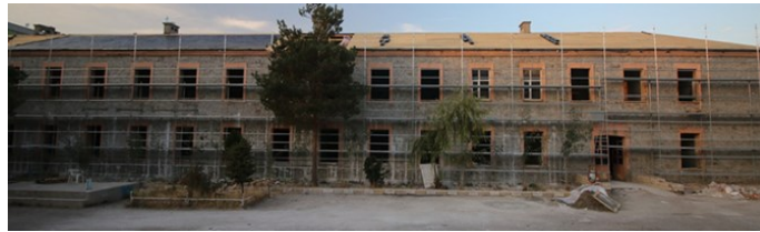
Şekil 6.45: Binanın Güney Cephesi Yarım Kalmış Hali (Yıldız, 2020)
