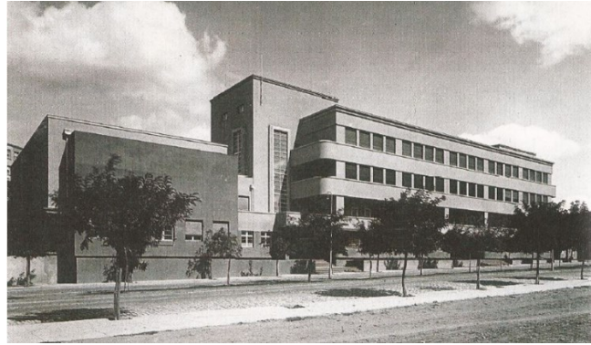
Şekil 4.42: İsmet Paşa Kız Enstitüsü Genel Görünüm (Hızlı, 2013).
