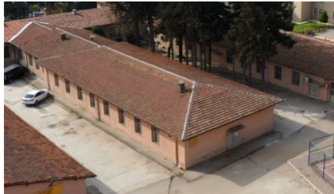
Şekil 5.40 Antakya Erkek Sanat Enstitüsü Atölye Bahçe Girişi ( URL 11)
