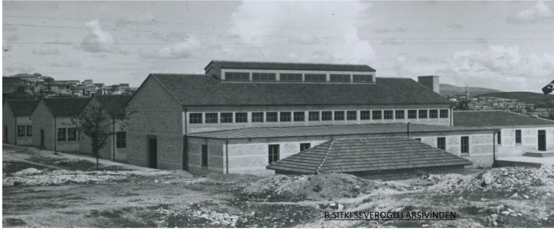
Şekil 5.28: Gaziantep Erkek Sanat Enstitüsü 1943 (Sacır, 2018)
