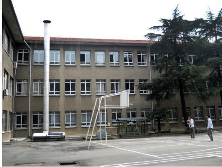
Şekil 4.61: Necati Beyi Kız Enstitüsü Güneybatı Cephesi (Durmuş,2016).
