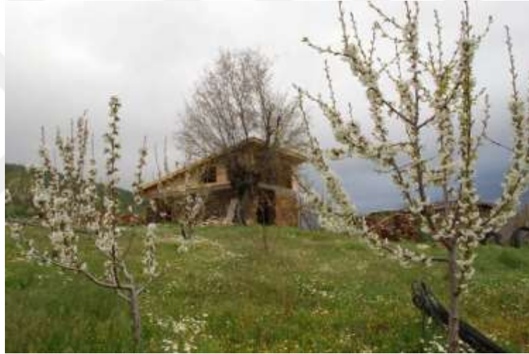
Şekil 2.148. Araştırma Enstitüsü Bina Görünümü ([Url-102], Erişim Tarihi: 17.12.2024).
