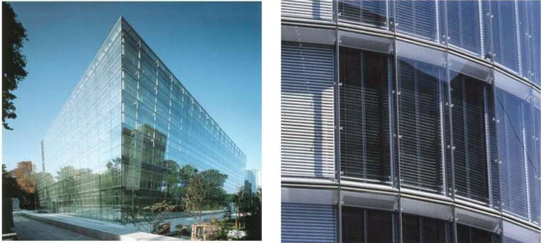
Şekil 2.11. Çift Kabuklu Bir Cephe Sistemi İçeren Victoria Ensemble Binası (Solda). ve RWE Yapısı (Sağda)
