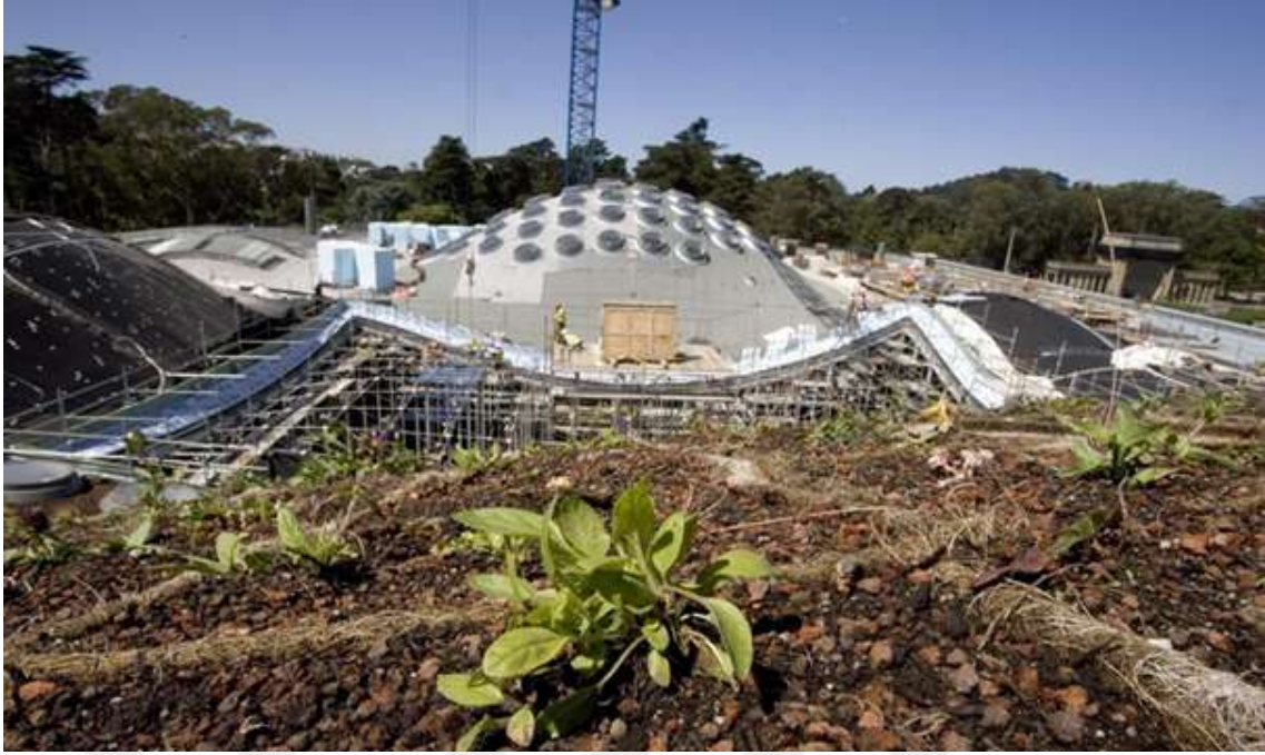
Şekil 2.35. California Bilim Müzesi'nin “Yeşil Çatısının” İnşaat Aşamasını Göstermektedir. [Url-15]
