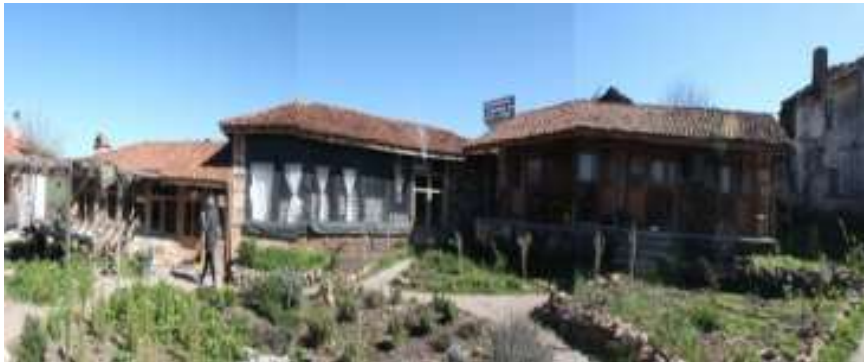
Şekil 2.149. Yerleşim Yerindeki Restorasyonu Yapılmış Yapılar (Kara,2014)
