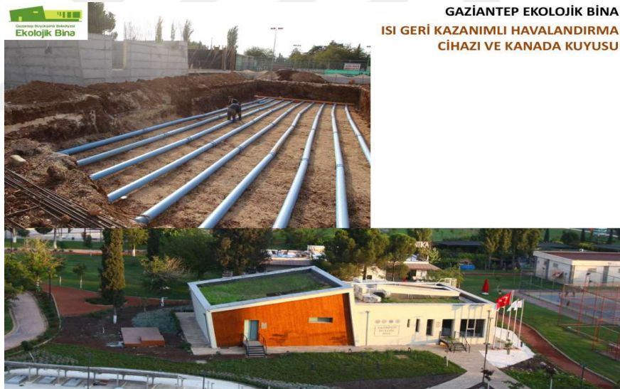
Şekil 2.99. Isı Geri Kazanımlı Havalandırma Cihazı ve Kanada Kuyusu
