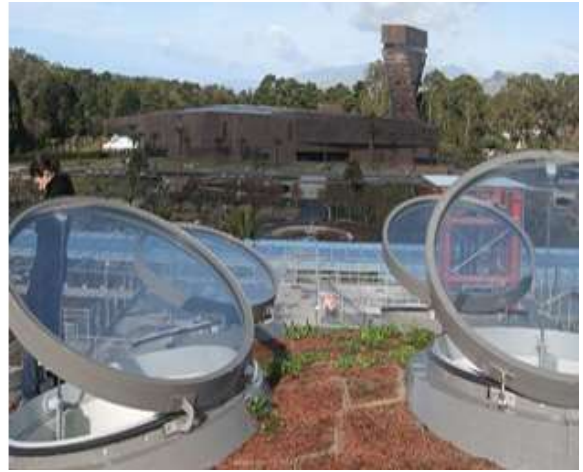
Şekil 2.38. California Bilim Müzesi'nin Çatısında Bulunan Havalandırma Kapaklarını Göstermektedir. [Url-16]
