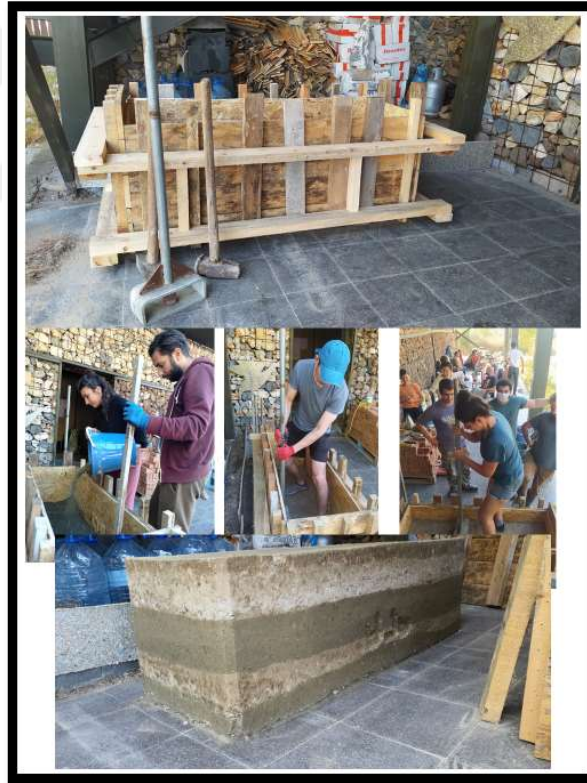
Şekil 4.11: Sıkıştırılmış Toprak İle İnşaa Tekniği Uygulamalı Gösterimi (Kaynak: Yazar)
