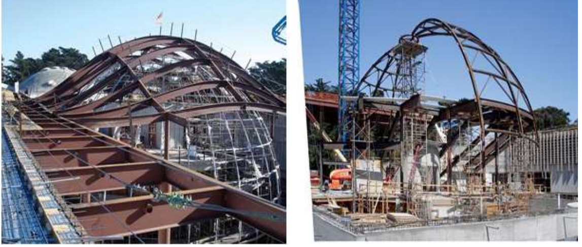
Şekil 2.31. California Bilim Müzesi'nin Yapısal Destek Sisteminden Görünüm. [Url-12]
