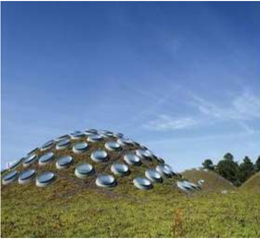
Şekil 2.38. California Bilim Müzesi'nin Çatısında Bulunan Havalandırma Kapaklarını Göstermektedir. [Url-16]
