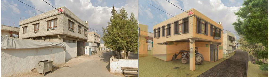
Şekil 4.9a: Mevcut Yapı Durumu Sazgın Köyü, 2024 (Kaynak: Yazar)
