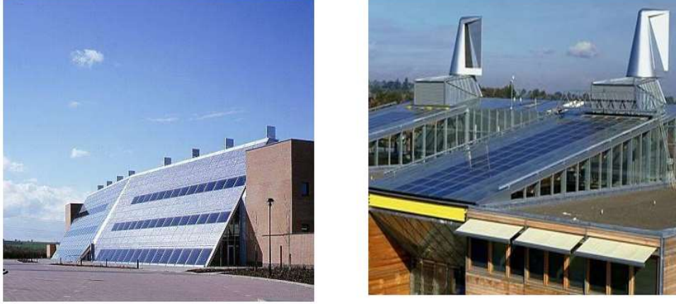
Şekil 2.10. Solar Office Doxford International Yapısında Güneş Enerji Paneli(Solda)- Nottingham Üniversitesi Jubilee Kampüsü Binasında Güneş Enerji Paneli(Sağda) (Url-4)
