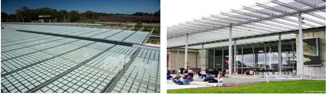
Şekil 2.39. California Bilim Müzesi'nin Saçaklarında Konumlandırılmış Pv Hücrelerini Göstermektedir. [Url-16]
