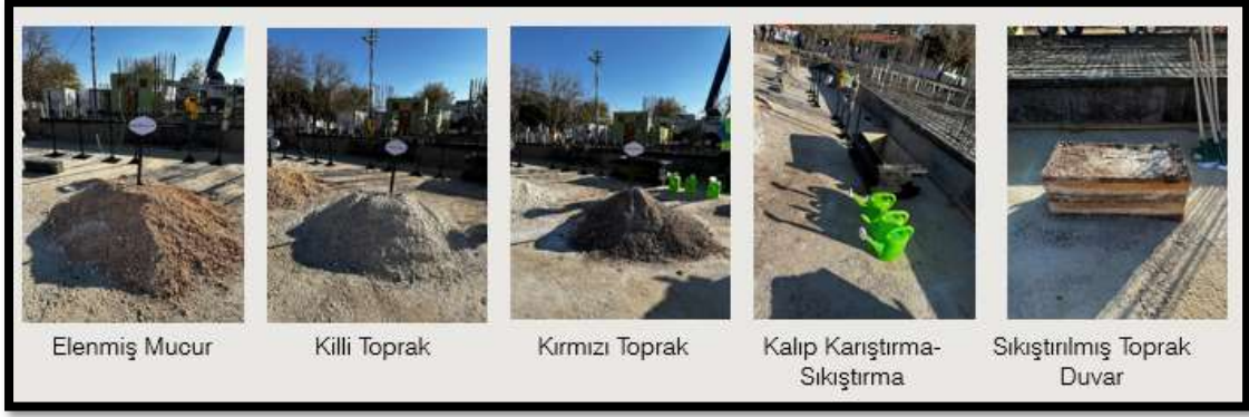
Şekil 4.12: Sazgın Ekolojik Köyü Deprem Sonrası Sıkıştırılmış Toprak İle İnşaa Tekniği Uygulamalı Gösterimi (Kaynak: Yazar)
