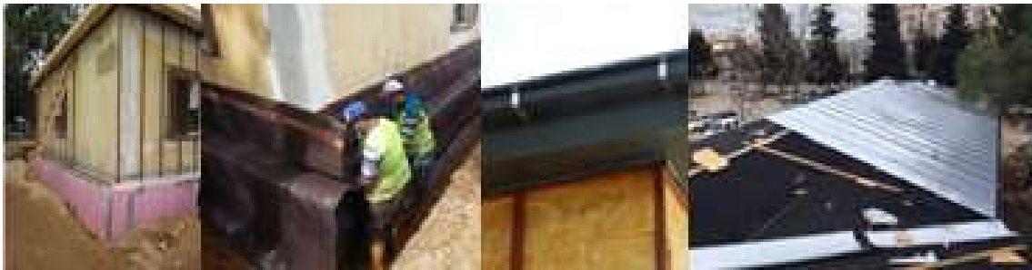
Şekil 2.117. Binanın Dış-Temel ve Duvarlarına Yalıtım Uygulanması [Url-40]
