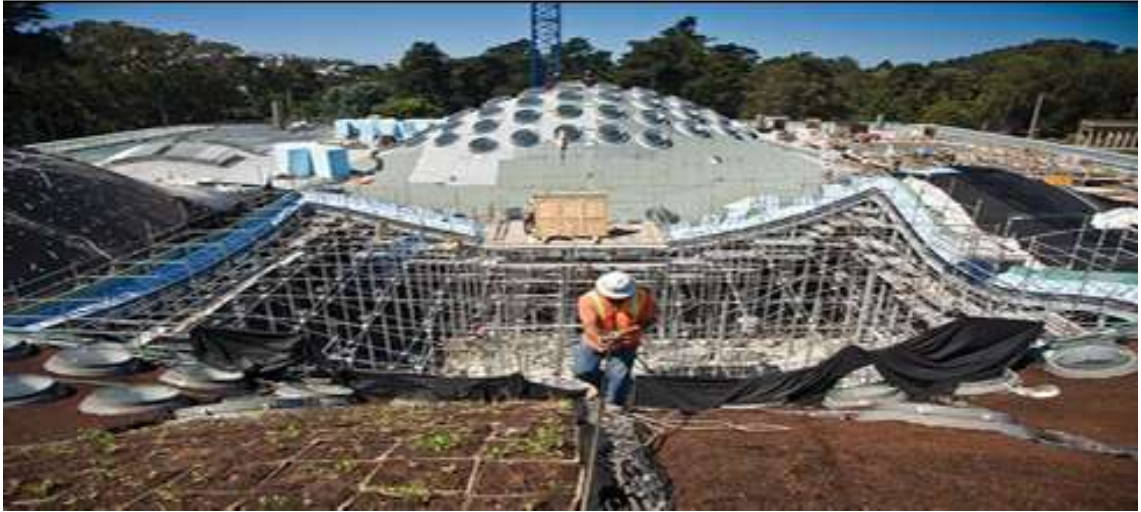
Şekil 2.34. California Bilim Müzesi'ndeki “Yeşil Çatı” Girişiminin İnşaat Aşamasından Görünüm. [Url-14]
