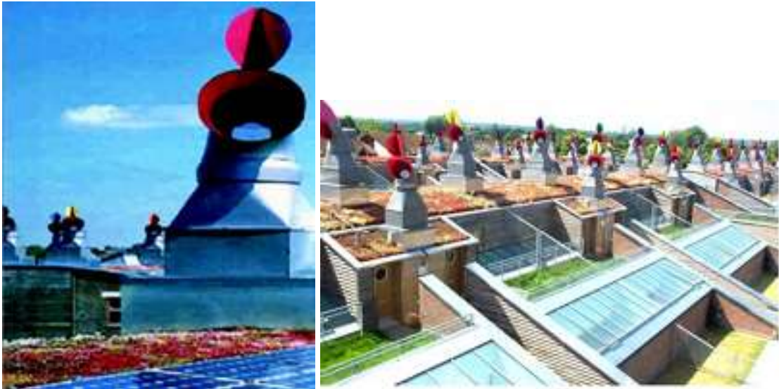
Şekil 2.41. İnşa Edilen Alanın Enerji Etkin Olarak Yapılandırılması Ve Kendi Kendine Yetebilen Bir Toplu Rüzgar İle Isı Geri Kazanımlı Havalandırma Oluşturan Rüzgar Bacaları (Akmalı Özçiftçi,2010)
