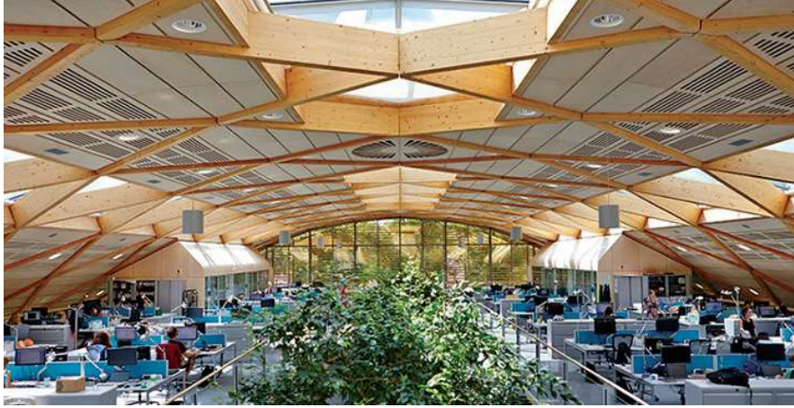
Şekil 2.50. Yapının İç Mekan Görünümü [Url-24]
