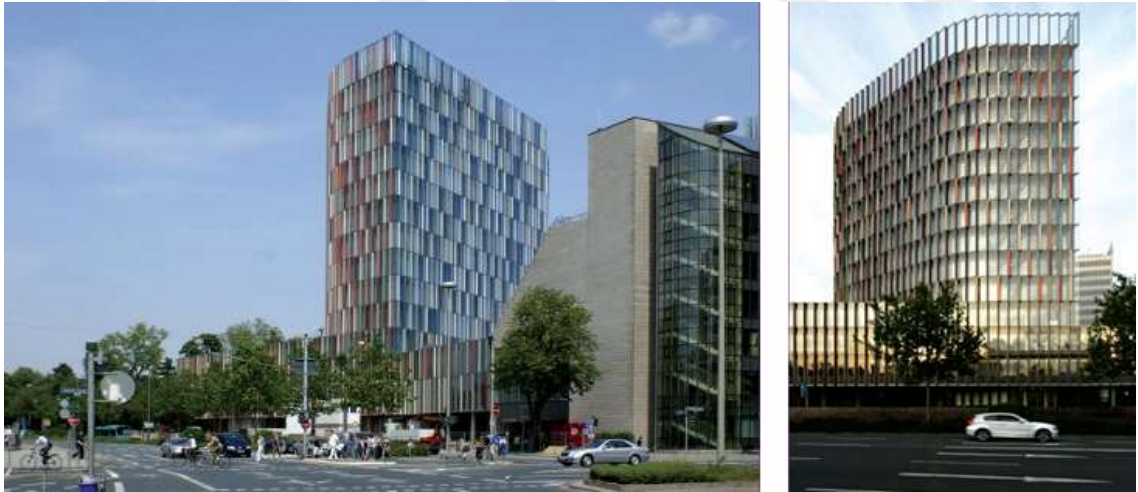
Şekil 2.51. Yapı Dışarıdan Görünümü [Url-25]
