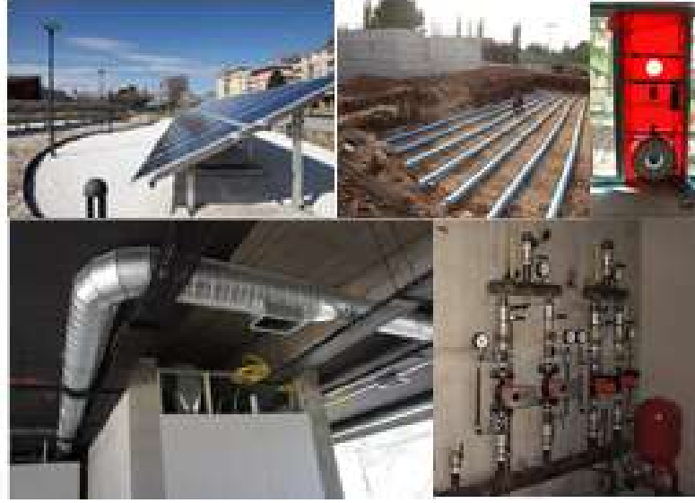
Şekil 2.103. Binanın Dışına Entegre Edilen Fotovoltaik Paneller- Kanada Kuyusu Sistemi- Havalandırma Boruları Ve Sistemi [Url-38]
