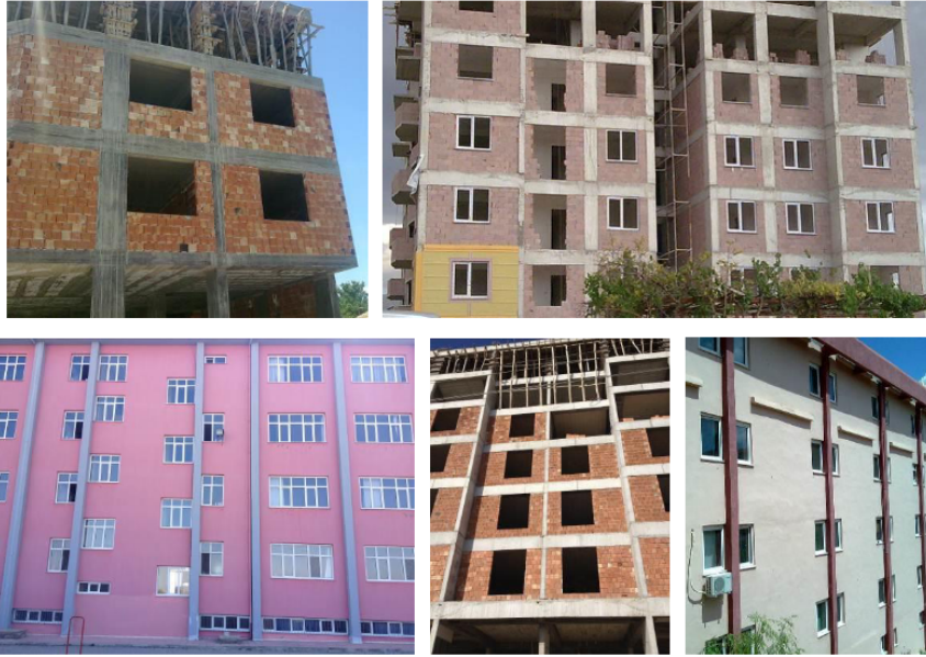
Şekil 2. Türkiye’de mevcut yapılarda uygulanan bazı pencere çeşitleri
