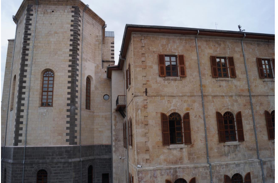
Şekil 8. 221. Restorasyonu Sürmekte Olan Latin Okulu Batı Cephesi (E.Y. Bakan,2019)
