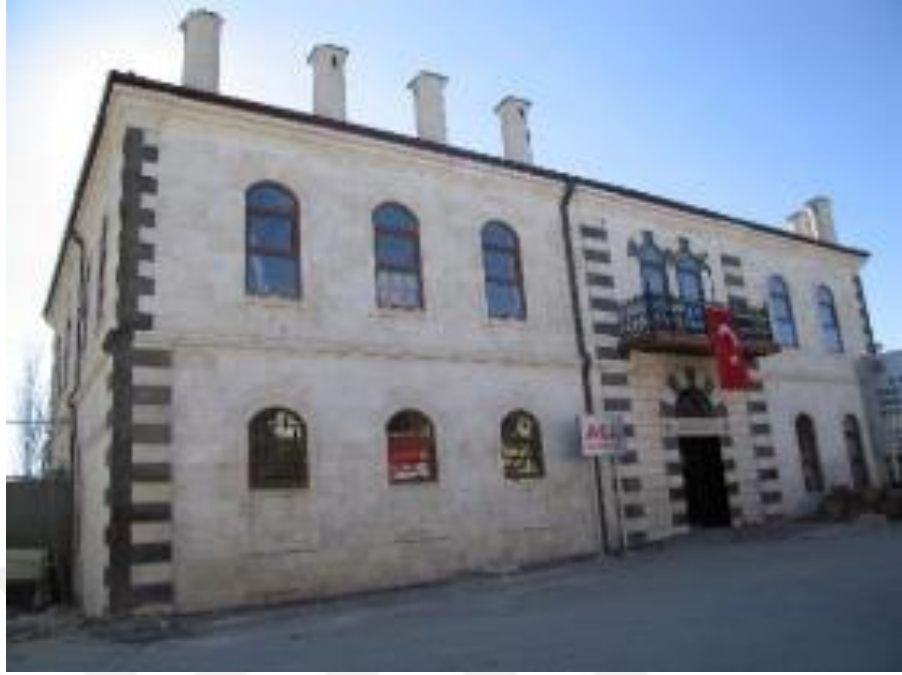
Şekil 8. 161. Acil Blok Restorasyon Sonrası (A. Uğraş Arşivi, 2015)
