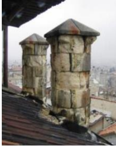
Şekil 8. 160. Çatı-Baca (A. Uğraş Arşivi, 2015)
