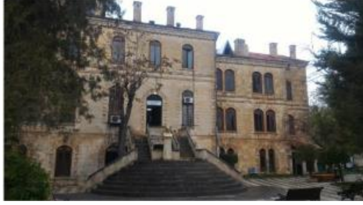
Şekil 8. 155. B Blok Güney Cephesi (A. Uğraş Arşivi, 2008)
