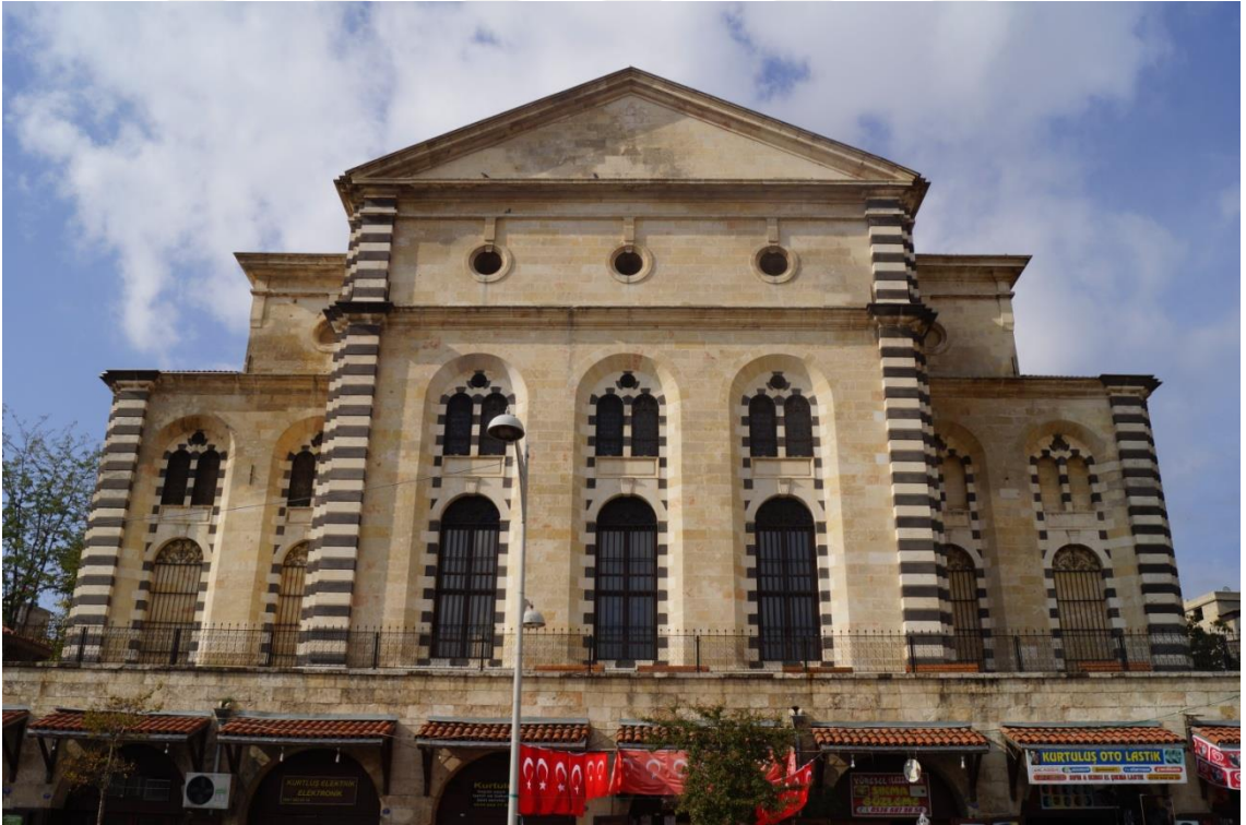
Şekil 8. 66. Kurtuluş Cami (Bakan E.Y., 2019)
