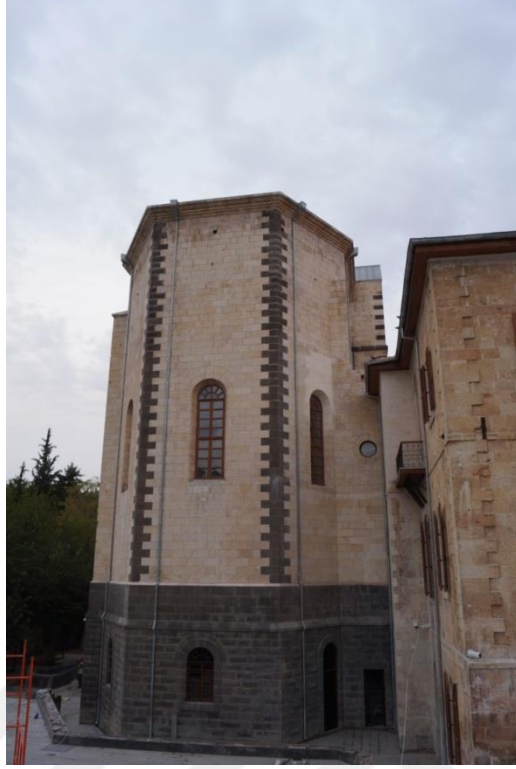
Şekil 8. 223. Restorasyonu Sürmekte Olan Latin Okulu Batı Cephesi (E.Y. Bakan,2019)
