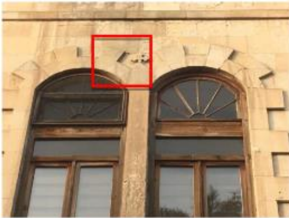
Şekil 8. 167. B Blok Güney Cephesi Merkezi Türkiye Koleji Arma Detayı (A. Uğraş Arşivi, 2018)
