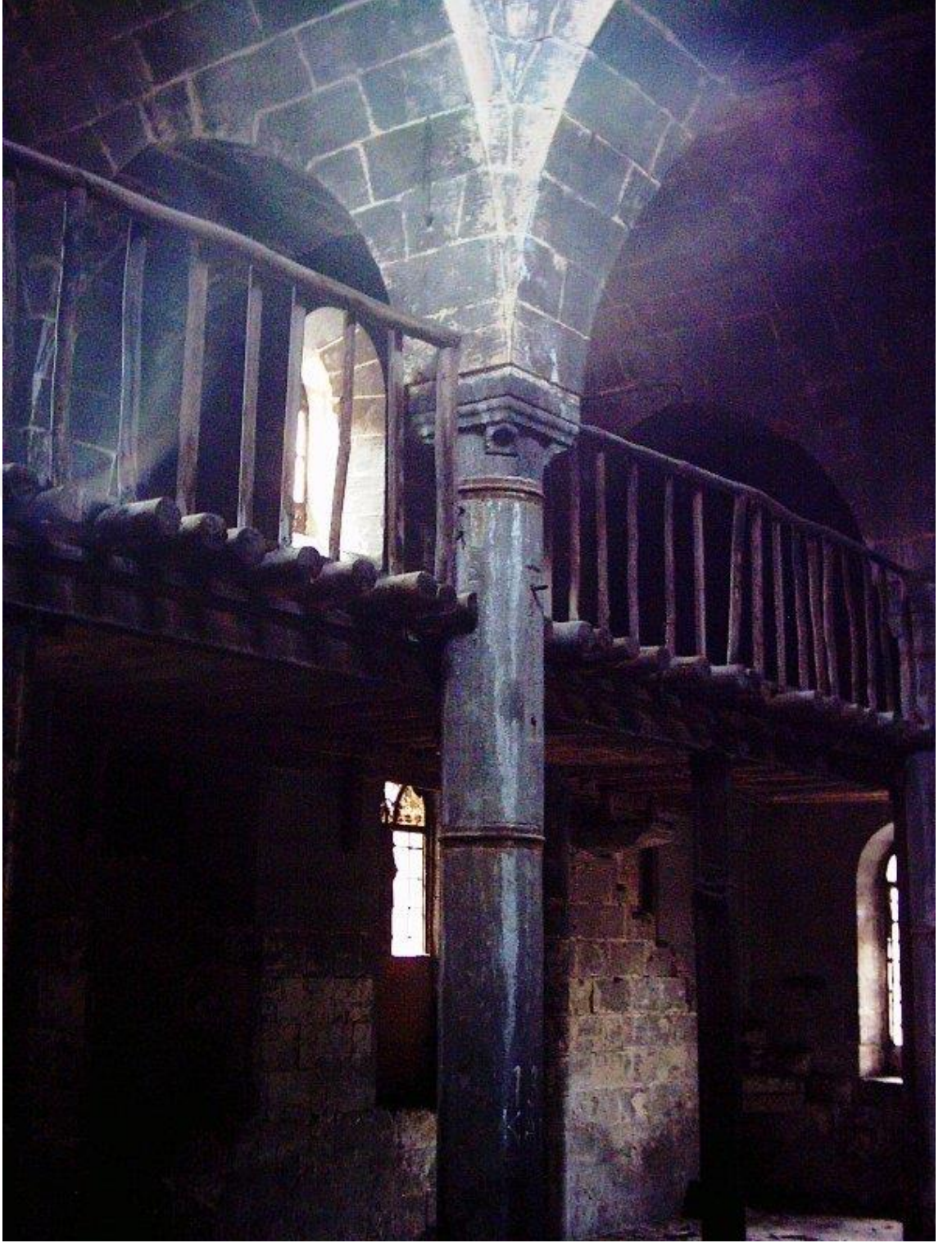
Şekil 8. 8. Aziz Bedros Kilisesi Restorasyon Öncesi Sütun ve Nef Görünüm (A.Uğraş, 2015)
