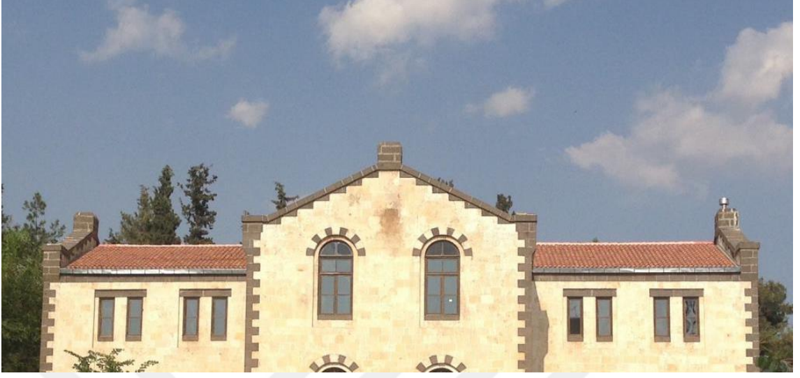
Şekil 8. 118. Merkezî Türkiye Koleji Çatı Görünümü Restorasyonu (Anonim, 2008)
