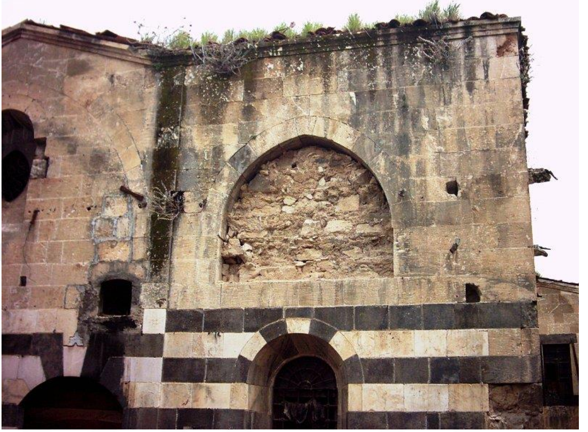
Şekil 8. 4. Aziz Bedros Kilisesi Restorasyon Öncesi (A.Uğraş, 2015)
