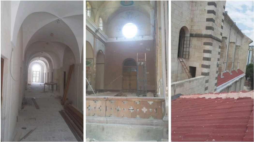
Şekil 8. 47. Kendirli Kilisesi Restorasyonda (A.Mihçioğlu,2019)
