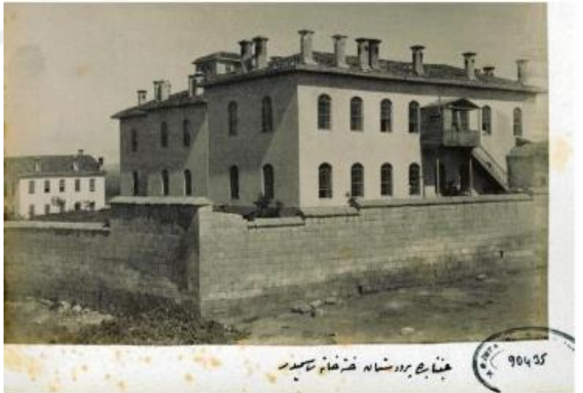
Şekil 8. 129. 1915, Yataklı Servis Binası (BCA, 2020)
