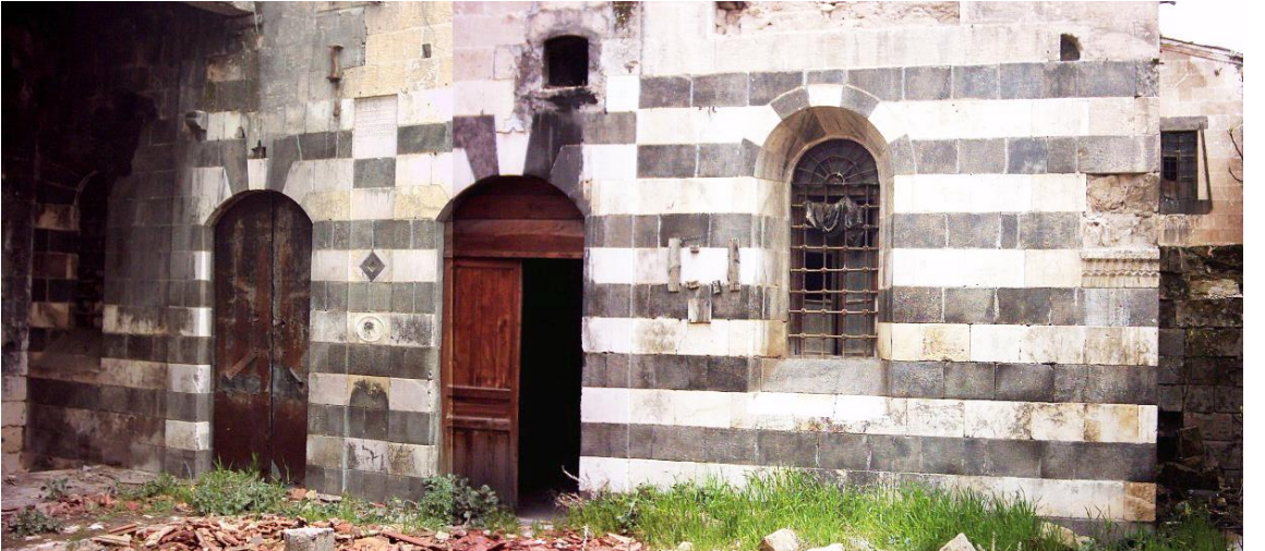
Şekil 8. 5. Aziz Bedros Kilisesi Restorasyon Öncesi (A.Uğraş, 2015)
