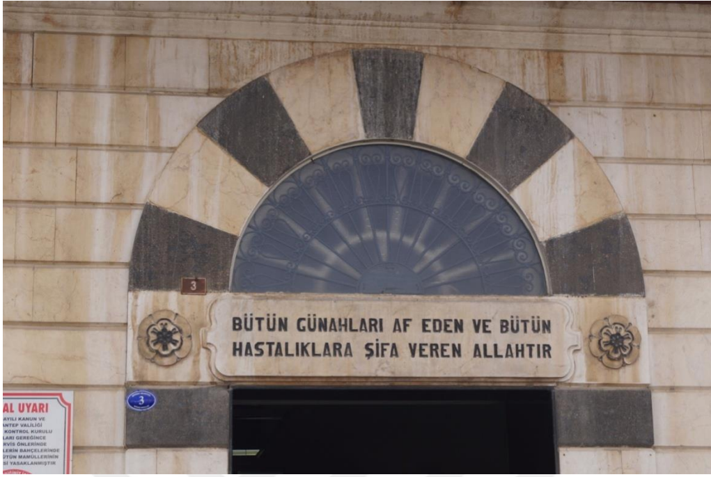
Şekil 8. 168. A Blok Giriş Kapısı Kemerli Kapı Yazı Detayı (A. Mıhçıoğlu Arşivi, 2019)
