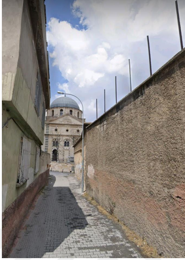
Şekil 8. 102. Restorasyonu Sürmekte Olan Vartanyan Anaokulu'nun Arka Duvarı (Zaim E., 2020)
