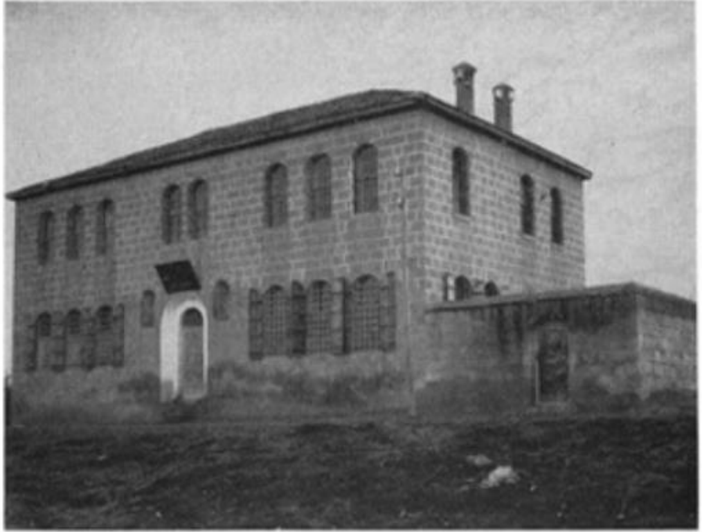
Şekil 8. 105. Kilikya Enstitüsü Ana Binası (Sarafian, 1957)
