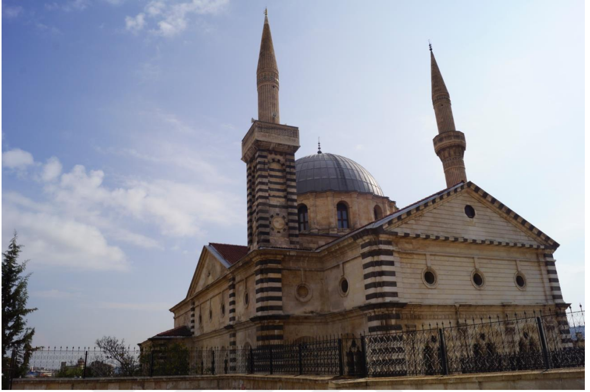
Şekil 8. 69. Kurtuluş Cami Kuzey Batı Cephesi (Bakan E.Y., 2019)
