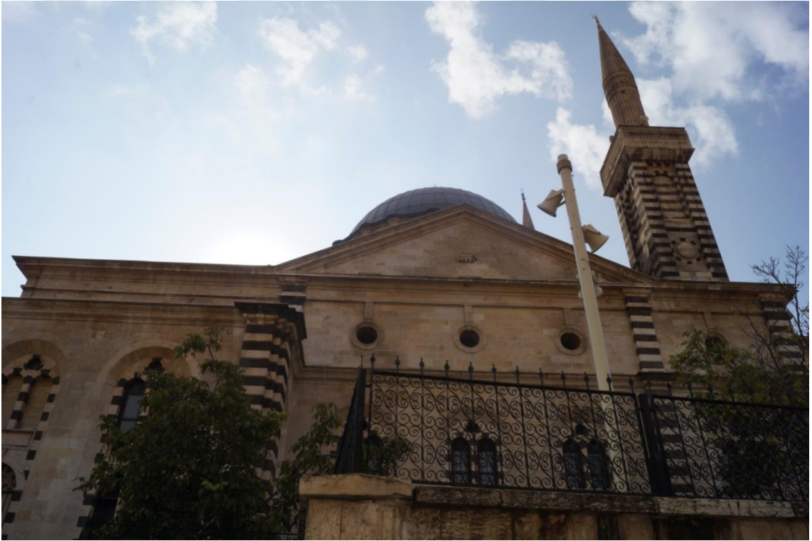
Şekil 8. 70. Kurtuluş Cami (Bakan E.Y., 2019)
