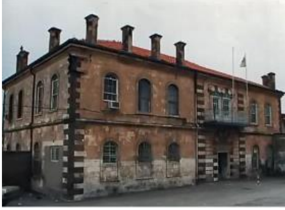
Şekil 8. 152. Acil Blok Restorasyon Öncesi (A. Uğraş Arşivi, 1995)
