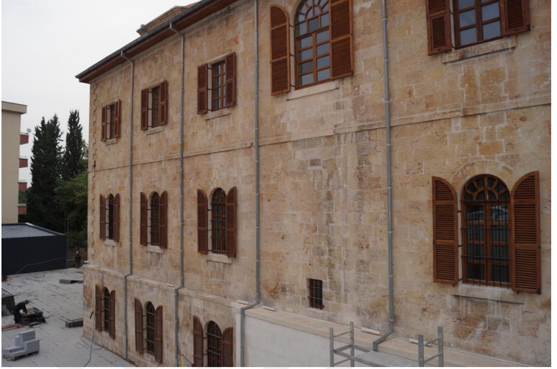
Şekil 8. 222. Restorasyonu Sürmekte Olan Latin Okulu Batı Cephesi (E.Y. Bakan,2019)
