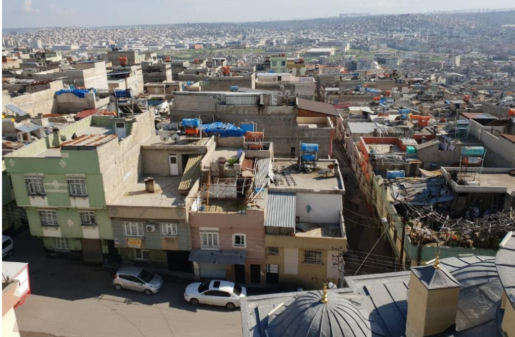
Şekil 5.17. Çıksorut Bölgesi Farklı Yükseklikte Binaların Görünümü (Kaynak: Karaaslan, M., 11.04.2019).
