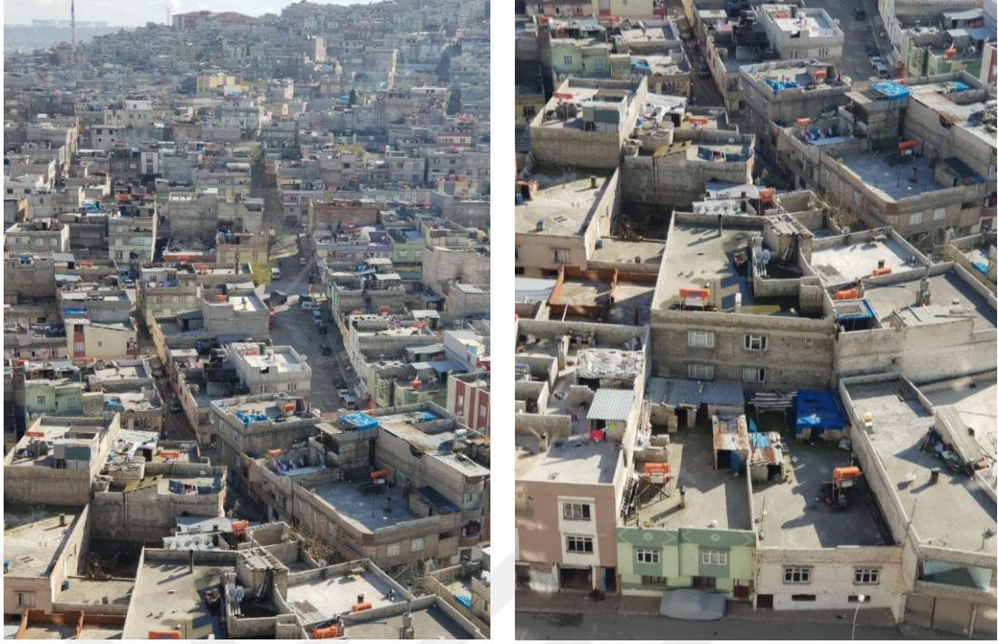
Şekil 5.15. Göllüce Mahallesi Bitişik ve Kompakt Binaların Görünümü (Kaynak: Karaaslan, M., 11.04.2019).
