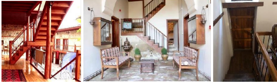
Şekil 4.28. Tematik Mutfak Müzesi'nde yer alan dış merdiven, Mahmut Arifi Konağı'nda yer alan iç merdiven, Kocabaşlar Konağı'nda yer alan iç merdiven (Özger, 2021).
