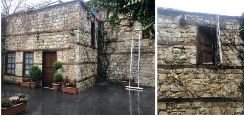
Şekil 6.4. Bahçede yer alan hizmetli evi; evin üst kat kapısı (Özger, 2021).
