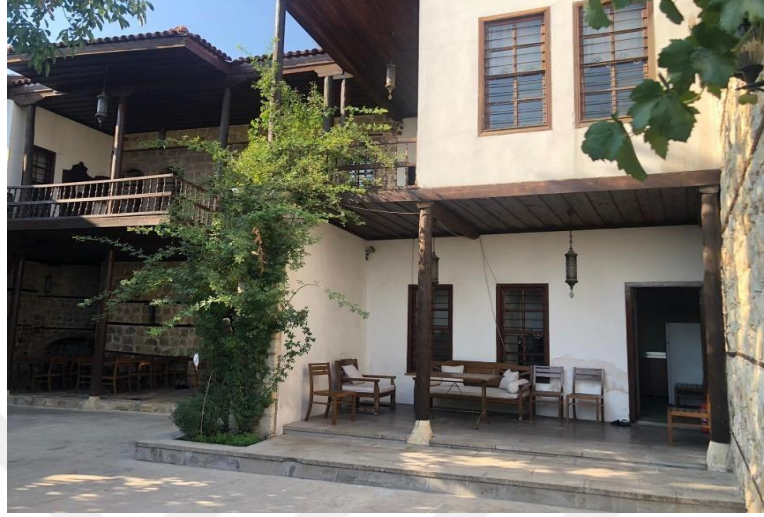
Şekil 4.34. Deligönüller Konağı'nda taş üzerine yerleştirilmiş, terası ve çıkma alanı destekleyen ahşap sütunlar (Özger, 2021).
