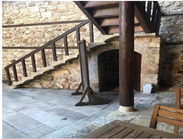
Şekil 5.25. Merdiven altına yerleştirilmiş hela (Özger, 2021).
