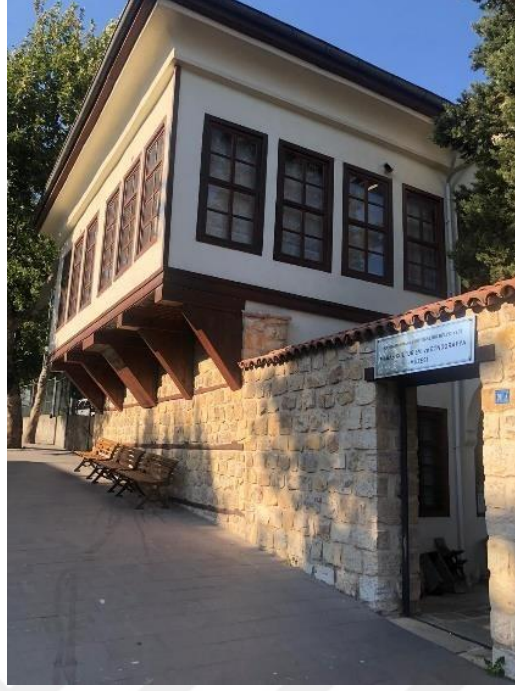
Şekil 5.60. Güneybatı cephesinden görünüm
