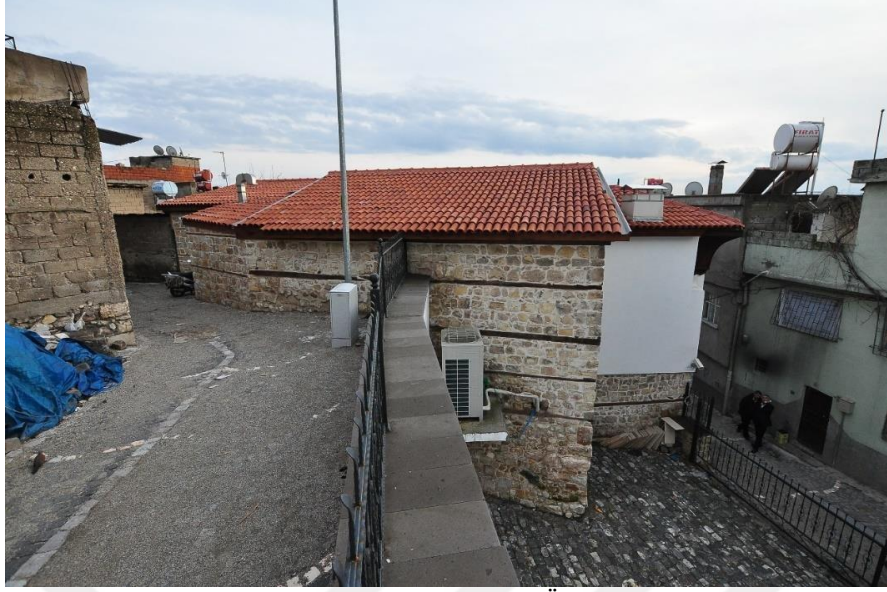
Şekil 5.37. Çatı görünümü (Özger, 2021).
