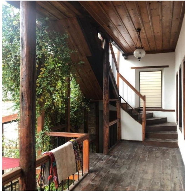
Şekil 6.11. Zemin kat balkonu ve selamlık girişi (Özger, 2021).
