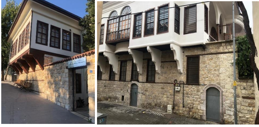
Şekil 4.32. Mahmut Arifi Konağı ve Kocabaş Konağı'nda yer alan kirişlerdeki ahşap destek elemanları (Özger, 2021).
