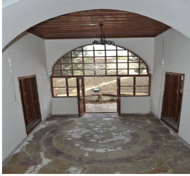
Şekil 5.62. Zemin kat eyvan bölümü içerden görünüm (Özger, 2021).
