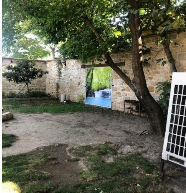
Şekil 5.55. Yapının kapanmış olan ilk girişi (Özger, 2021).
