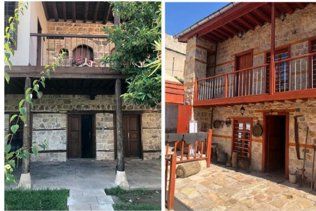
Şekil 4.45. Köker Konağı, Tematik Mutfak Müzesi iç avlu cephesi (Özger, 2021).
