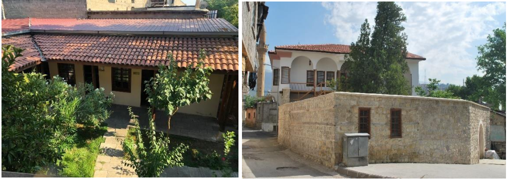
Şekil 4.48. Köker Konağı avlusunda yer alan çatı, Kocabaşlar Konağı çatısında kemer birleşim formu çıkma açık alan sarkaçları, sokak görünümünden (Özger, 2021).
