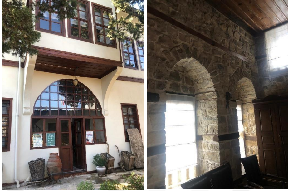
Şekil 4.24. Mahmut Arifi Paşa Konağı'nda yer alan pencereler avlu görünümü, Kocabaş Konağı'nın bodrum katta yer alan kemerli taş yapıli pencereler (Özger, 2021).
