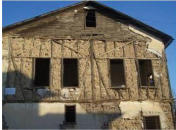
Şekil 4.43. Kerpiç Duvar örneği, Envanter No. 36 (Paköz, 2013).
