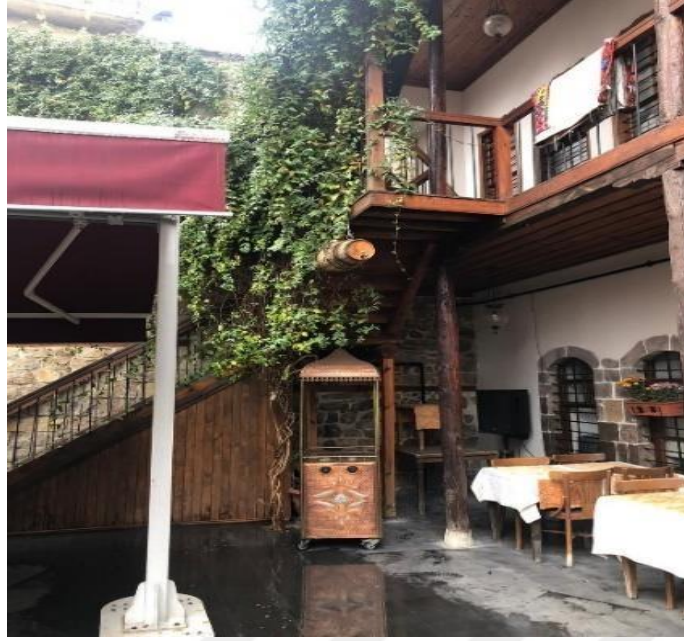
Şekil 6.10. Zemin kat balkon dođu görünümü (Özger, 2021).
