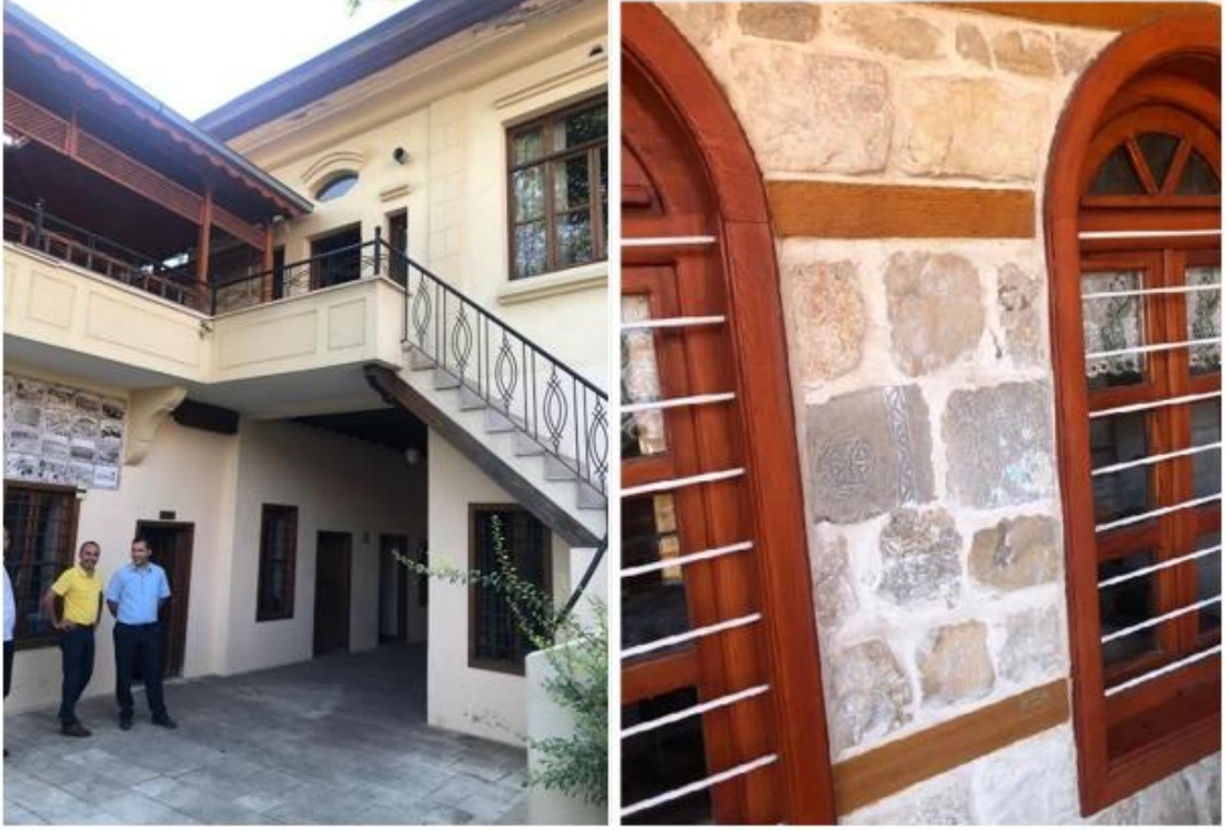
Şekil 4.30. Köker Konağı'nda zemin kat pencerelerinde ve merdiveninde yer alan korkuluklar, Tematik Mutfak Müzesi zemin kat pencerelerinde yer alan yatay korkuluklar (Özger, 2021).
