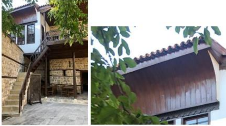
Şekil 4.38. Deligönüller Konağı'nda yer alan iç bükey saçak çıkmaları (Özger, 2021).
