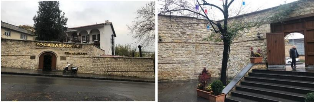
Şekil 6.3. Avlu kapısı sokak görünümü ve içeriden görünüm (Özger, 2021).
