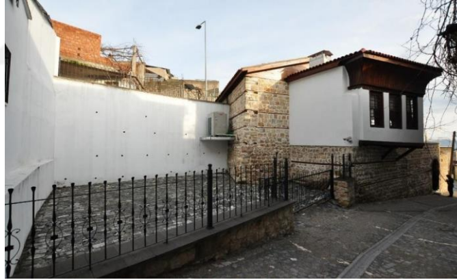
Şekil 5.38. Sokak cephesi (Özger, 2021).
