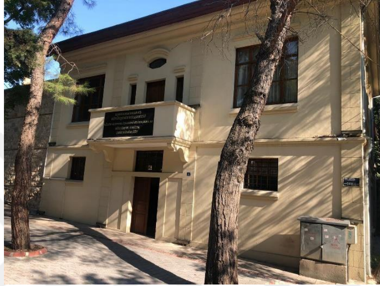
Şekil 5.53. Konağın yeni giriş kapısının olduğu sokak cephesi genel görünüm (Özger, 2021).
