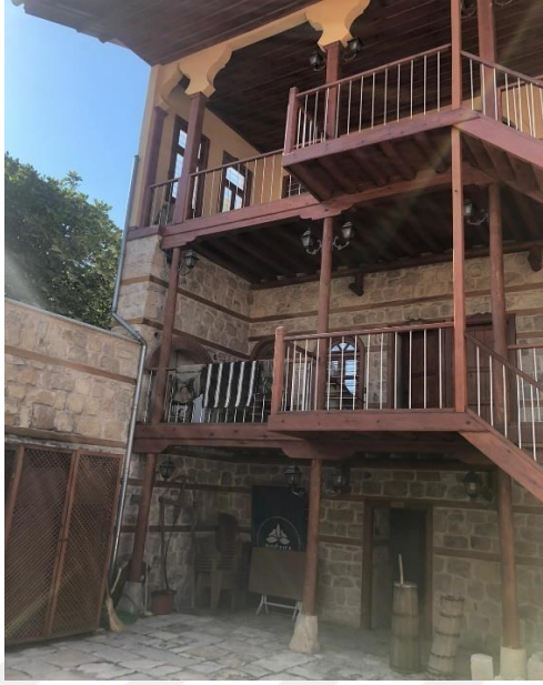
Şekil 5.7. Yapının avludan güney cepheden odunluk giriş görünümü (Özger, 2021).
