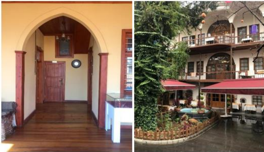
Şekil 4.35. Tematik Mutfak Müzesi'nde yer alan bağdadi kemer, Kocabaş Konağı'nda ikinci kat terasında yer alan sütun üstü kemerler (Özger, 2021).
