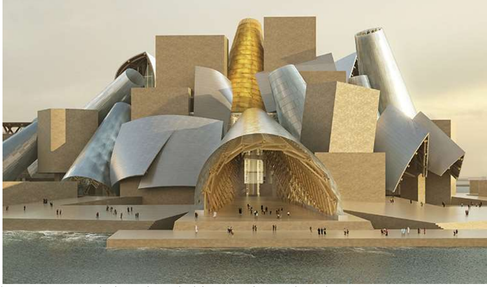
Şekil 2. 27. Guggenheim Abu Dhabi Müzesi. Frank Gehry.
