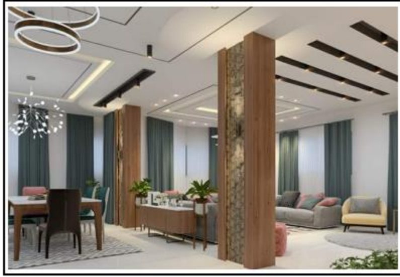
Şekil 12: Taş malzeme ile kaplanarak ve ahşap plakalarla iki yandan genişletilerek tasarlanan, yemek yeme alanını ve oturma alanını sınırlayan kolon tasarımı (URL-12, 2022)
