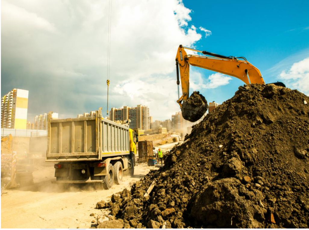
Şekil 2.2. Sahada hafriyat çalışması (URL-1)
