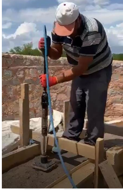
Şekil 2. 24. Kompaktör ile sıkıştırılmış kerpiç duvar yöntemi, (Işık,2015)
