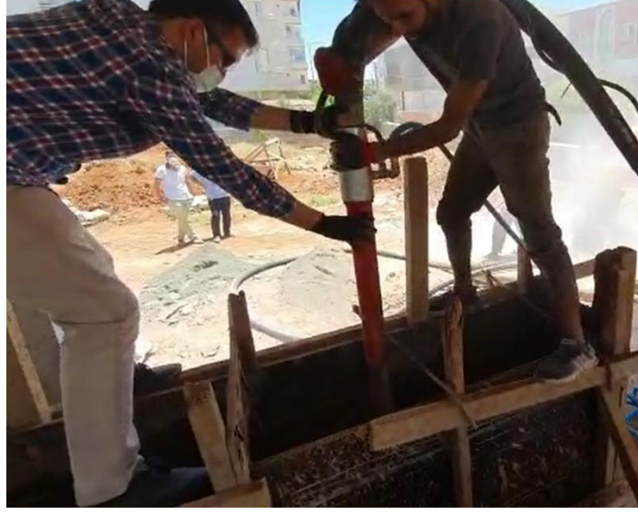
Şekil 5. 9. Shotcrete eğitiminin verilmesi (Özcan, 2021)
