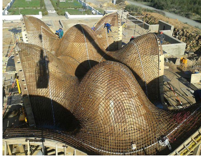
Şekil 4. 6. Karmaşık planlı çatıların inşası (URL 8)
