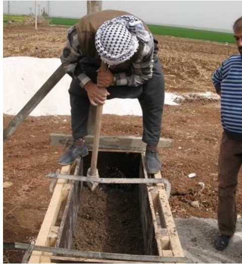
Şekil 2. 23. Tokmak ile sıkıştırılmış kerpiç duvar yöntemi, (Işık,2011)
