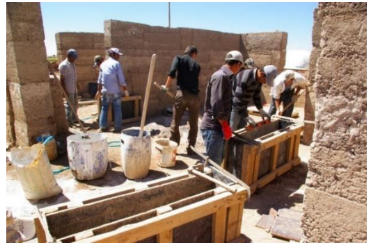
Şekil 3. 12: Sandık kalıp ve tokmaklama ile Alker duvar yapımı (Işık,2011)
