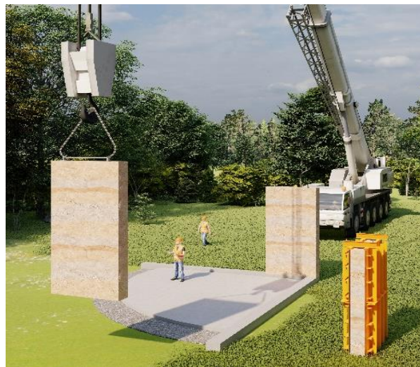
Şekil 2. 27. Donatılı plakaların taşınması, Çizer S. T. Özcan
