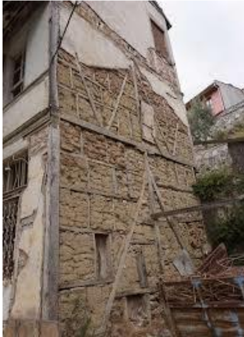
Şekil 2. 25. Hımış duvar örneği (Aktaş,2018)
