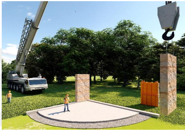
Şekil 2. 26. Kalıp içerisinden çıkartılma, Çizer S. T. Özcan
