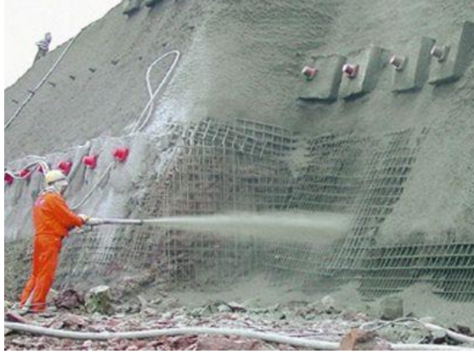
Şekil 4. 5. İstinat duvarı ve iksa sistemi inşası (Url 7)
