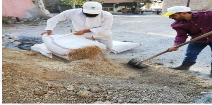
Şekil 2. 13. Kerpiç harcı için uygun killi toprak ve saman karıştırılarak hazırlanıyor.
