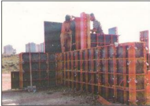
Şekil 3.4: Endüstriyel kalıp montajı (Işık,1995)
