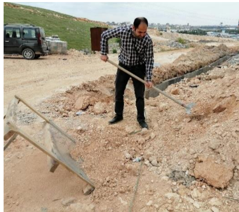
Şekil 5. 6. Toprağın elenmesi (Özcan, 2019)
