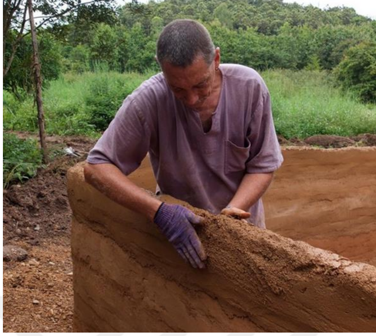
Şekil 2. 22. El ile şekillendirilen kerpiç duvar yöntemi, (URL 5).
