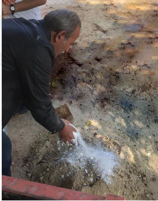
Şekil 5. 8. Kuru karışımın uygulama sırasında el ile karılma işlemi (Özcan, 2020)
