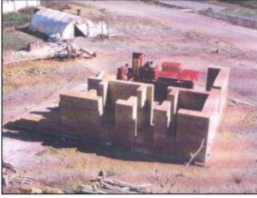
Şekil 3. 6: Kalıp sökülmesi (Işık,1995)
