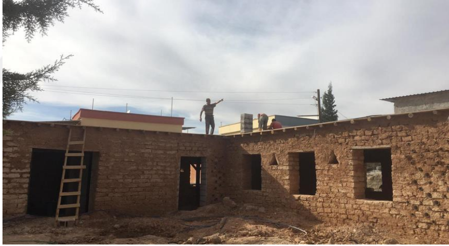
Şekil 2. 17. Kerpiç blokları duvar elemanı olarak kullanılması, (Özcan,2018)
