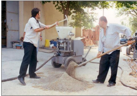
Şekil 3. 8. Alker harcının shotcrete makinesine aktarılması (Işık,2002)
