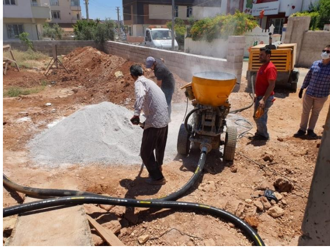
Şekil 5. 14. Kuru karışımın makineye aktarılması (Özcan, 2021)
