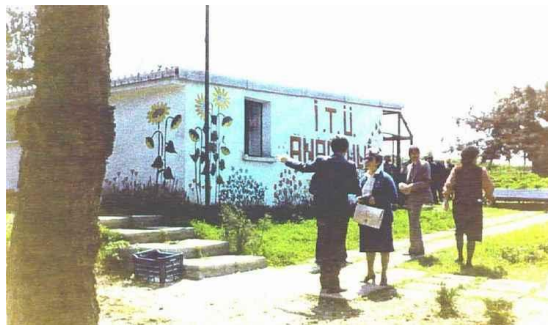
Şekil 3. 3. İTÜ Anaokulu binası (Işık,1995)
