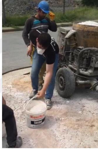
Şekil 5. 11. Kuru karışımın makineye aktarılması (Özcan, 2019)
