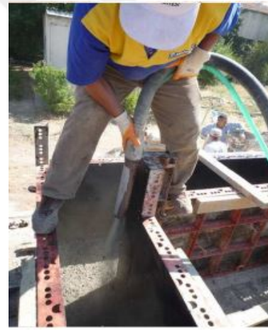
Şekil 4.78. Shotcrete ile duvar kalıbının doldurulması (Url-50)
