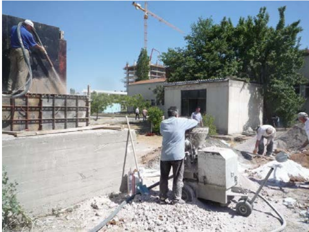
Şekil 4.77. Ankara sarsma tablası Shotcrete ile inşaat (Işık, 2013)
