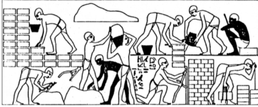
Şekil 4.10. Mısır'da kerpiç duvar inşaatı (Url-24)
