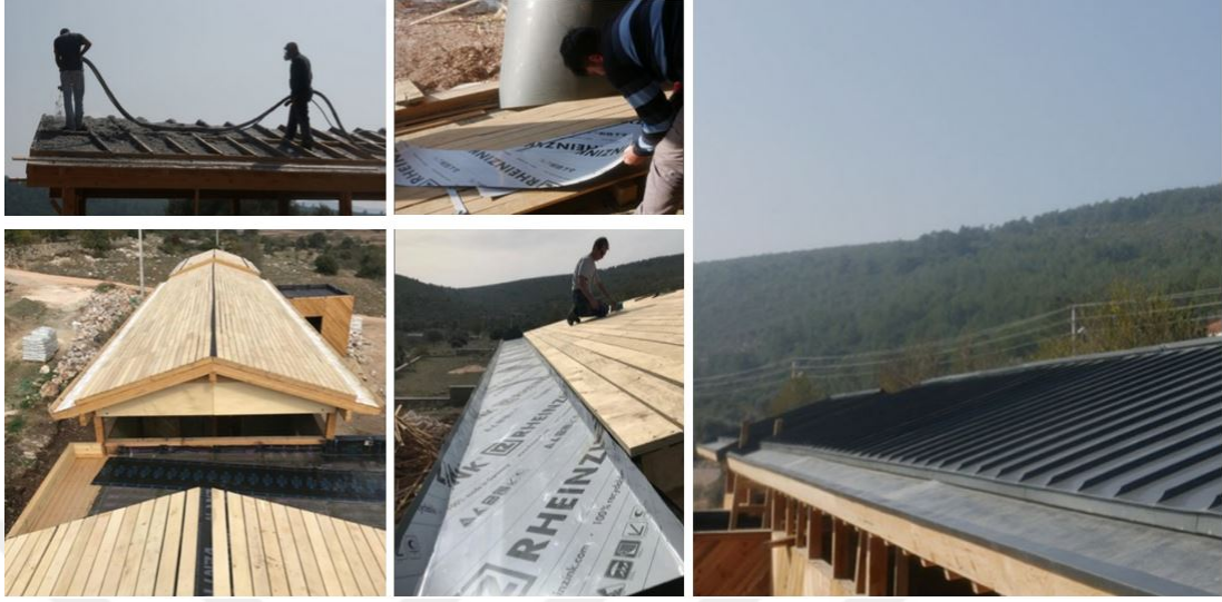
Şekil 5.23. Kıрма çatı örtüsü uygulama aşamaları
