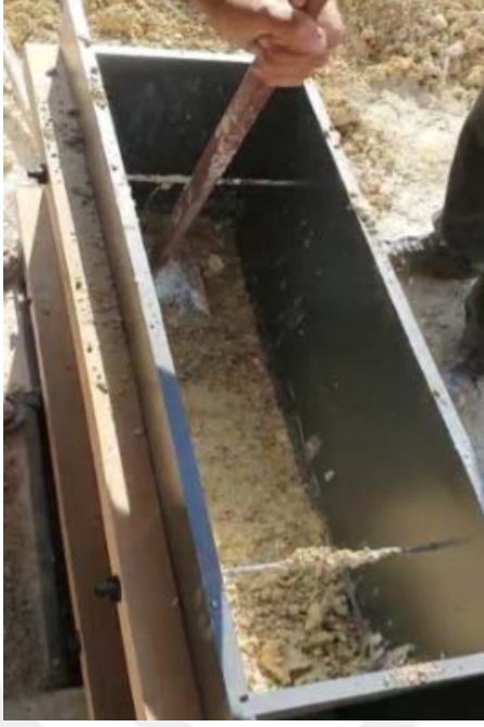
Şekil 4.41. Kalıp içerisinde karışımın işleme (P. Öztürk, 2020)
