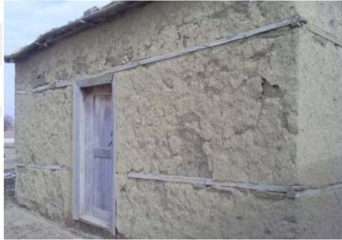
Şekil 4.62. Ankara Bala (2007) Depremi'nde kerpiç yapı hatıl ile korunmuş (Işık, 2017)
