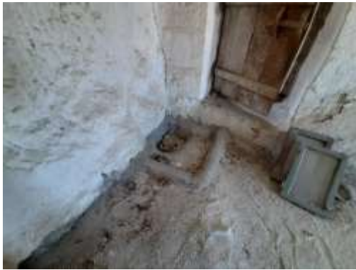
Şekil 3.34: I01'deki beton-toprak zemin (2020)
