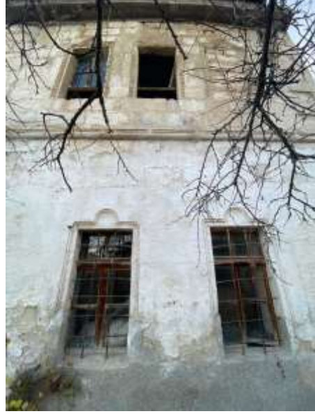
Şekil 3.44: Cephedeki pencereler ve kat silmesi (2020)
