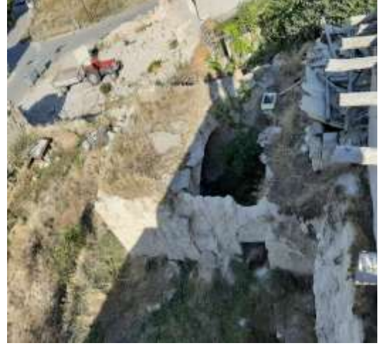
Şekil 4.2: Z07 tandır odasının yıkılan tavanı (2020)
