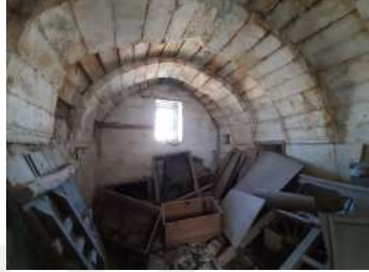
Şekil 3.37: B02’deki taş kemer tavan kaplaması (2020)
