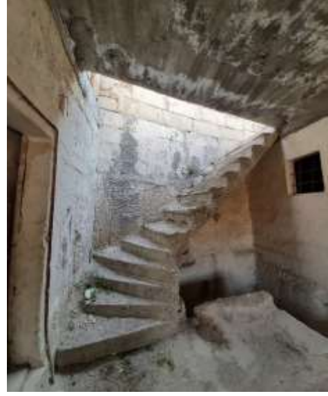
Şekil 3.33: I02'den çatıya çıkan merdiven (2021)
