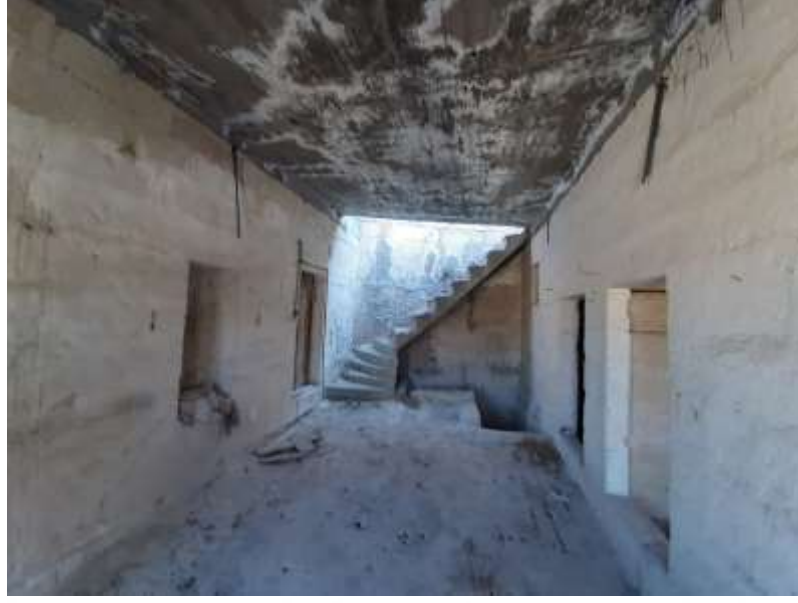
Şekil 3.22: I02'den I01, I03, I04 ve çatıya geçiş görüntüsü (2020)
