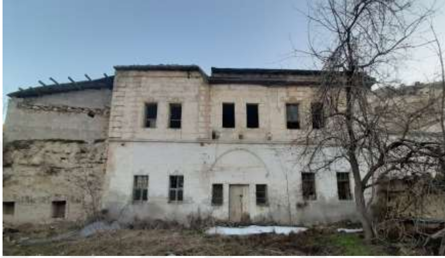
Şekil 3.42: Yapı Kuzey Cephesi (2020)
