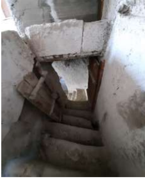
Şekil 3.32: Z03'den I02'ye bağlanan merdivendeki ahşap kapı (2020)
