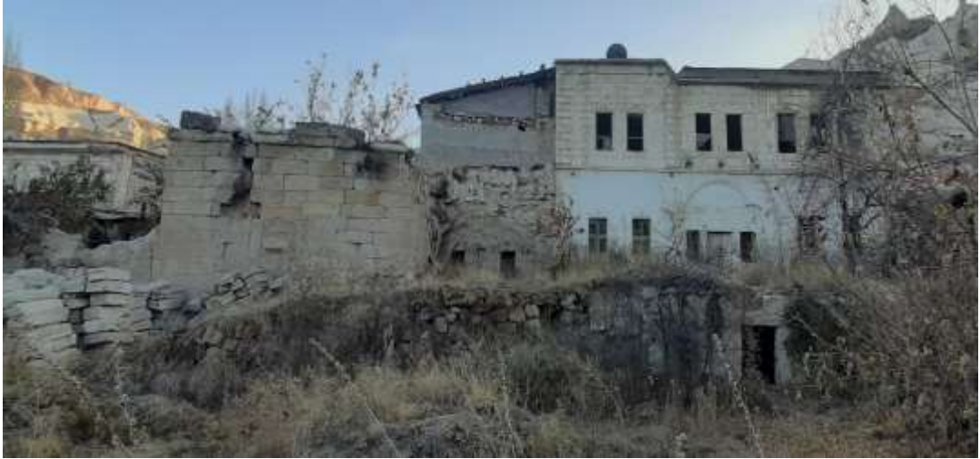
Şekil 3.41: Yapı Kuzey Cephesi(2020)
