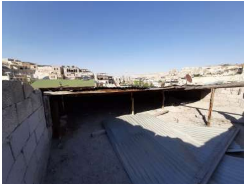
Şekil 3.29:+7.19 kotlu çatıdan görüntü (2021)
