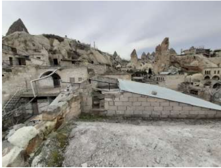
Şekil 3.28:+7.92 kotlu damdan görüntü (2021)
