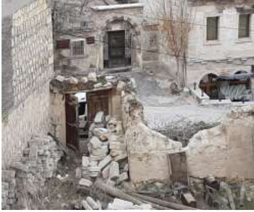
Şekil 3.30: Bahçe dış duvarlar (2020)
