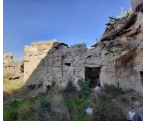
Şekil 3.50:Toprak kotuna yakın yerlerde su ve nemden kaynaklı erimiş ve yüzey kaybına uğramış taşlar (2020)
