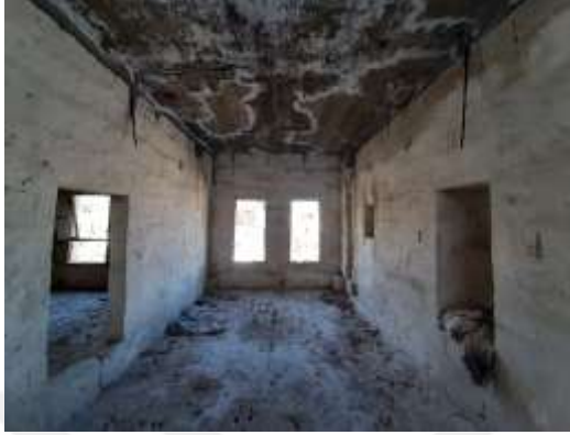
Şekil 3.36: I01’deki muhdes betonarme tavan (2020)
