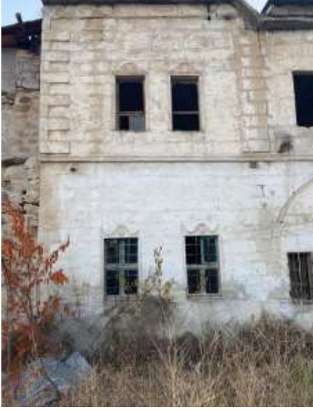
Şekil 3.43: Cephedeki dökülmeler (2020)
