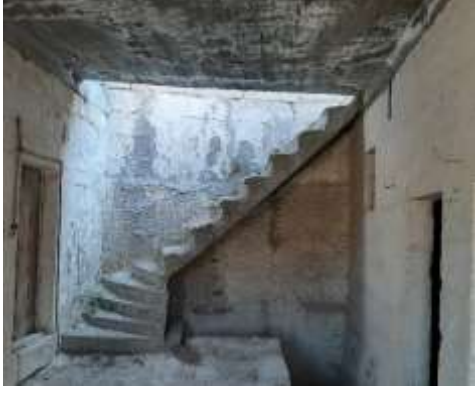
Şekil 4.4: I02'deki muhdes merdiven ve betonarme tavan (2020)
