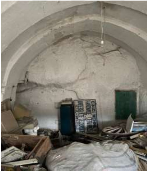
Şekil 5.1: Z04 No'lu odanın mevcut görünümü (2020)
