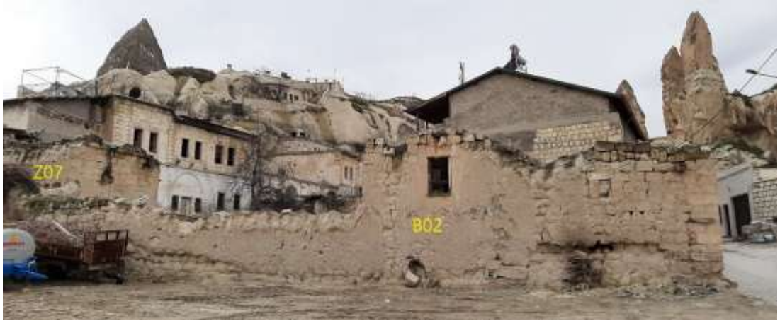
Şekil 3.39: Doğu Bahçe Duvar Cephesi (2020)
