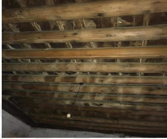
Şekil 4.19. Ahşap kirişleme görüntüsü
