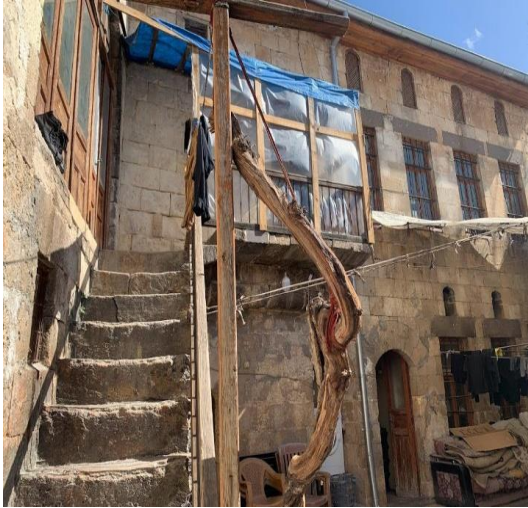
Şekil 4.31. Geleneksel yapılarda görülen muhdes ek örnekleri
