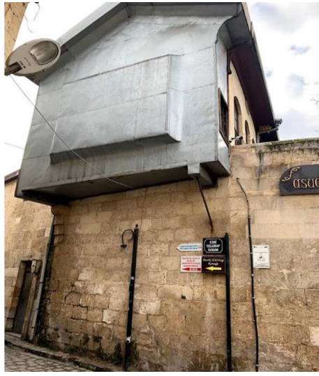
Şekil 4.29. Cephelerde dökülme, tuzlanma, kabuklanma ve biyolojik bozulma
