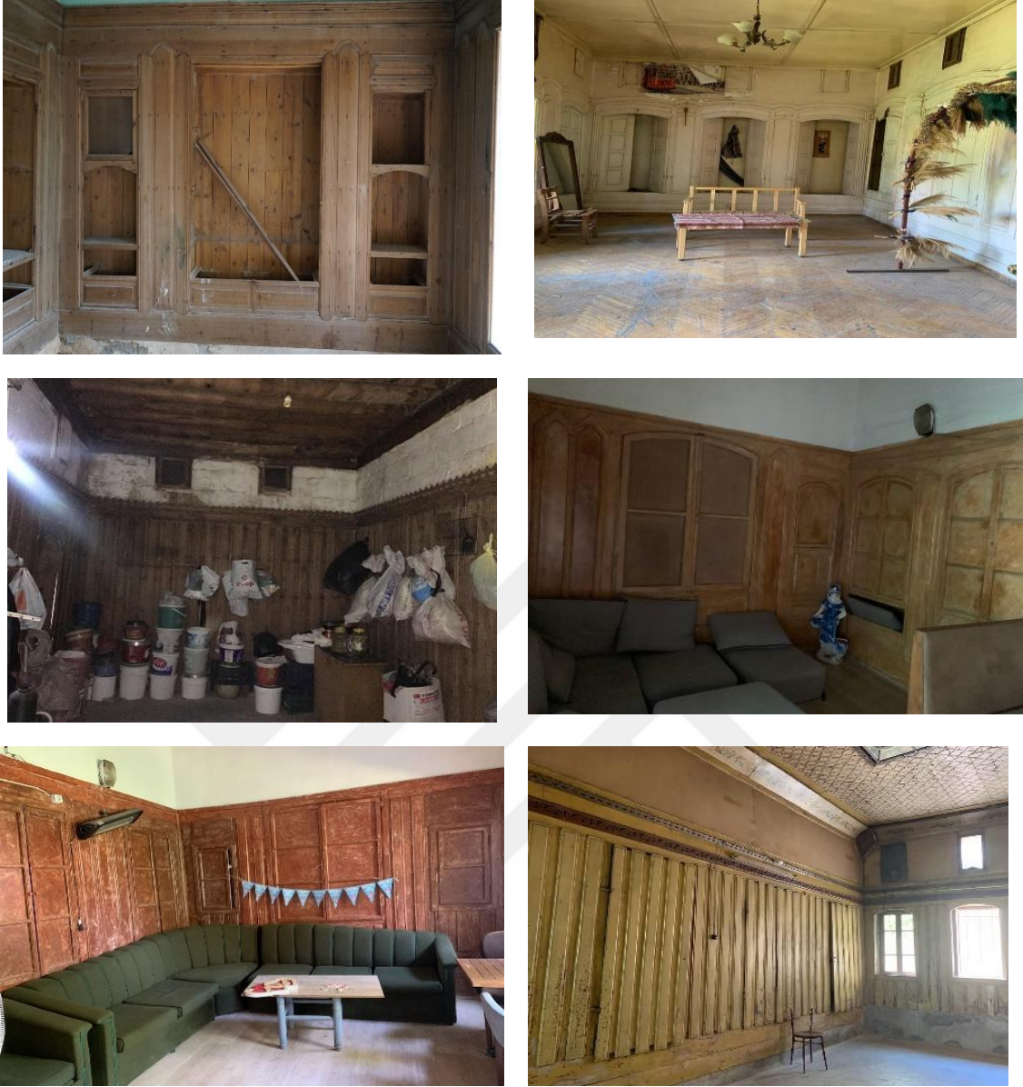
Şekil 4.10. Geleneksel Gaziantep evlerinde nacar kaplama örnekleri
