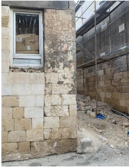
Şekil 4.29. Cephelerde dökülme, tuzlanma, kabuklanma ve biyolojik bozulma
