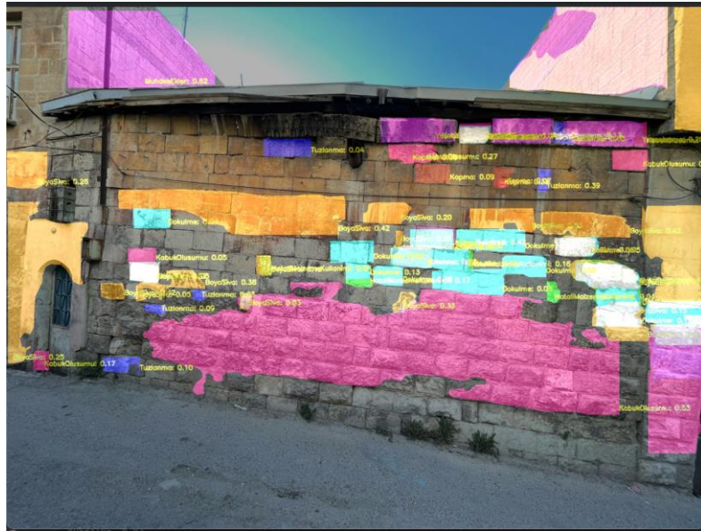
Şekil 4.59. 677 Ada 46. Parsel sokak cephesi görüntüsü, bozulma haritası, yapay zeka destekli bozulma haritası tahmini
