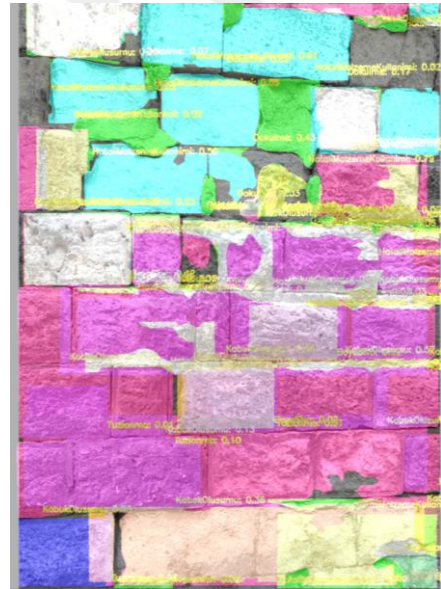
Şekil 4.60. 677 Ada 46. Parsel sokak cephesi görüntüsü ve yapay zeka destekli bozulma haritası tahmini
