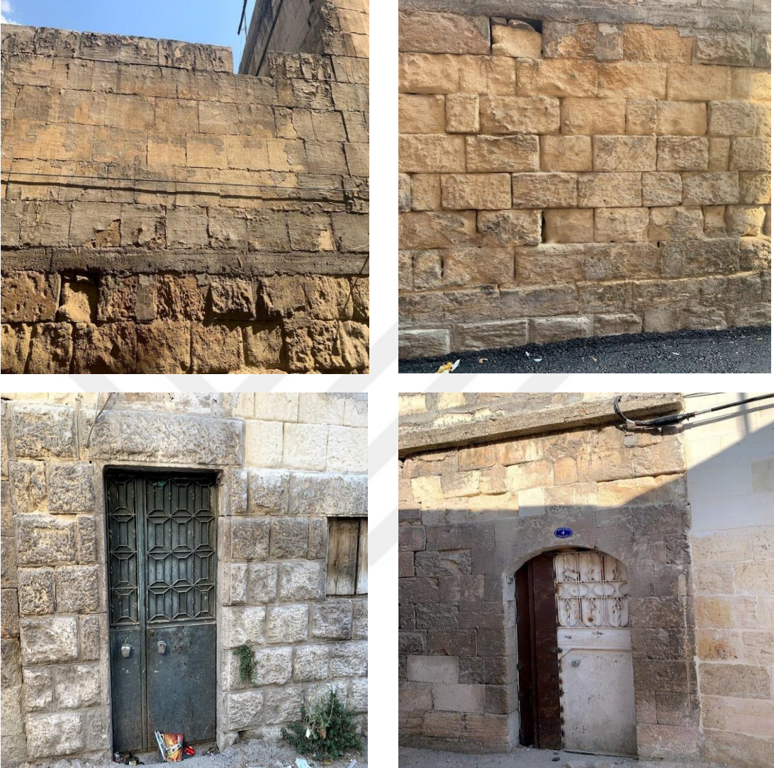
Şekil 4.24. Hava kirliliği etkisiyle malzeme yüzeyinde görülen kabarma, kabuklanma ve dökülme
