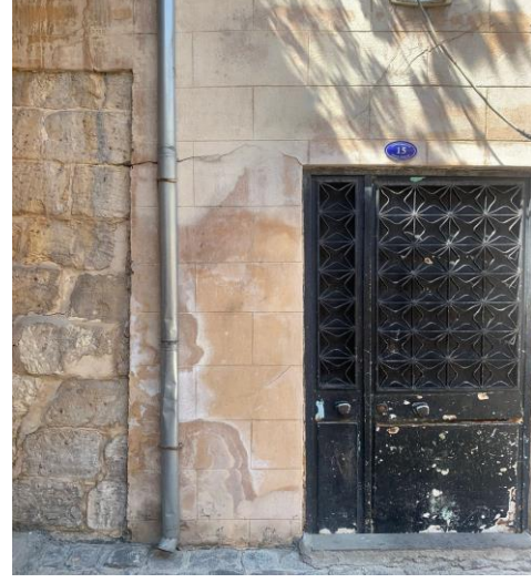
Şekil 4.26. Yapı yüzeyinde nem etkisiyle bozulma
