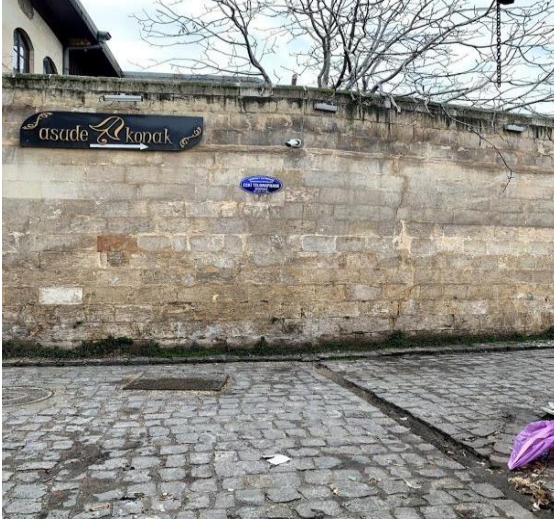
Şekil 4.26. Yapı yüzeyinde nem etkisiyle bozulma
