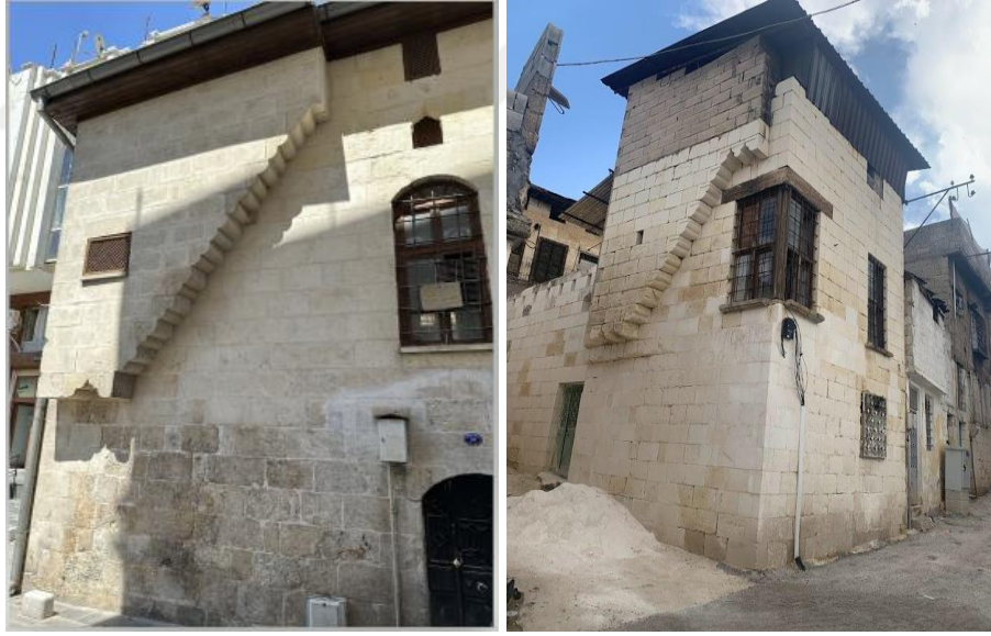
Şekil 4.16. Sokak cephesine taşınan merdiven görüntüsü
