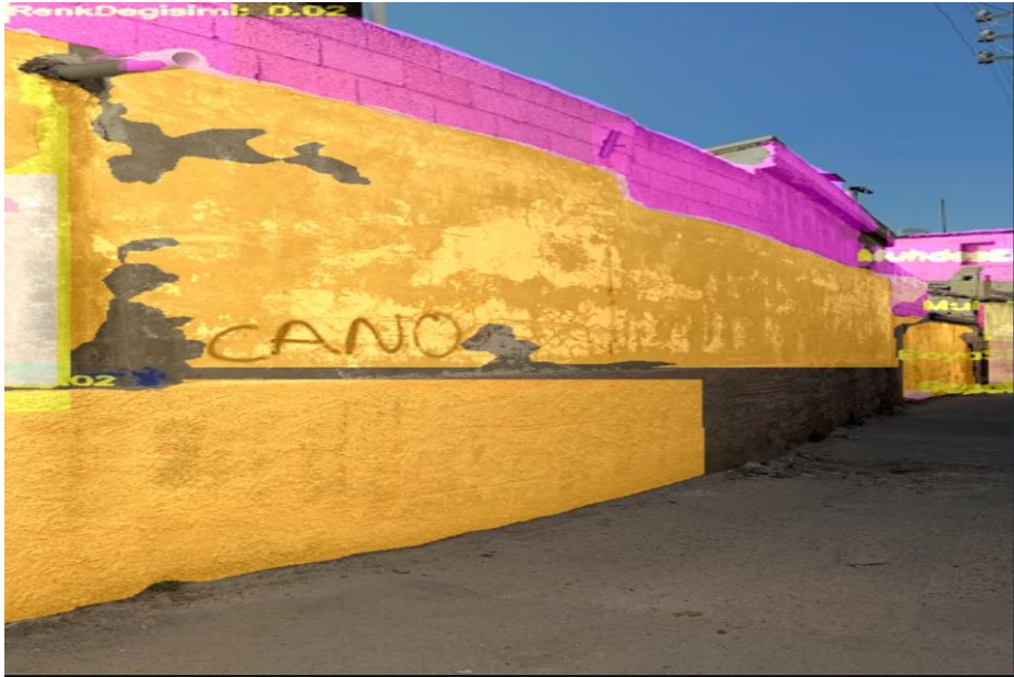
Şekil 4.56. 677 Ada 4. Parsel sokak cephesi görüntüsü, bozulma haritası, yapay zeka destekli bozulma haritası tahmini
