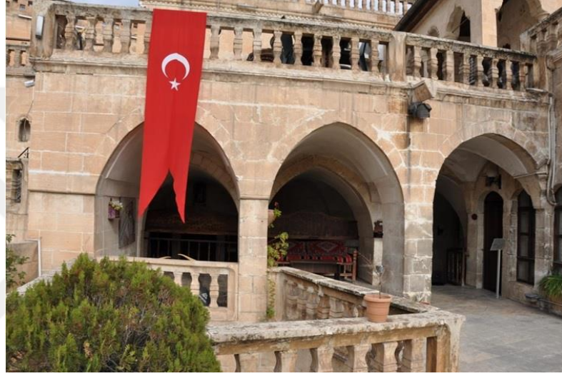
Şekil 4.100. Akçarlar Evi Sivri Kemerli, Çapraz Tonoz Örtülü Eyvan Bölümü (Cevher Mimarlık)
