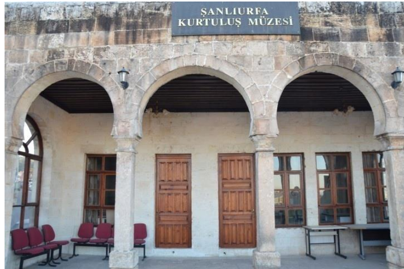
Şekil 5.82. B Blok Avludan Görünüş(Ağar, 2021)
