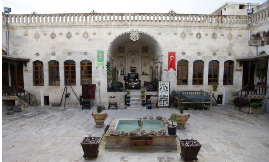
Şekil 4.11. Hacıbanlar Konağı Avlunun Güney Kenarı (Ağar, 2021)
