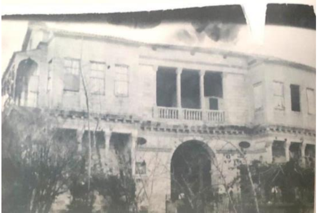
Şekil 5.4. Mahmut Nedim Kürkçüođlu Konađı'nın Dođu Cephesi'nin 1940'lı yıllarda görünümü (Nedim Kürkçüođlu Albümü)
