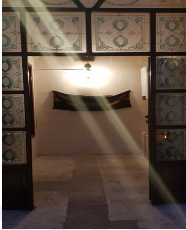
Şekil 4.58. Fuat Billurcu Evi 1K-02 Ahşap Malzemeyle Kapatılmış Eyvan (Ağar, 2021)
