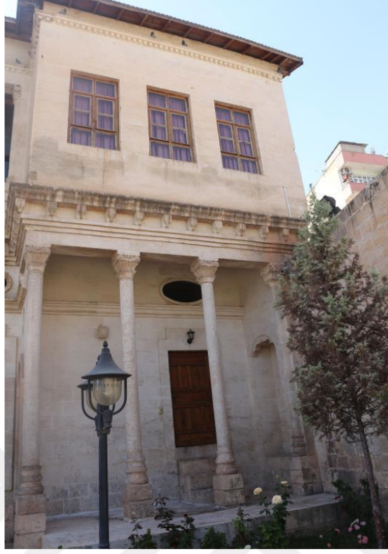
Şekil 5.46. Mahmut Nedim Kürkçüođlu Konađı A Bölümü Cephe Detayı (Ađar, 2021)
