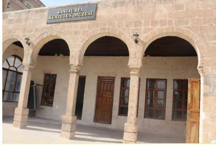
Őekil 5.63. Mahmut Nedim Kürkçüođlu Konađı Güvenlik Odası Ve Ortak Dinlenme Alanı Cephe Detayı(Ađar, 2021)
