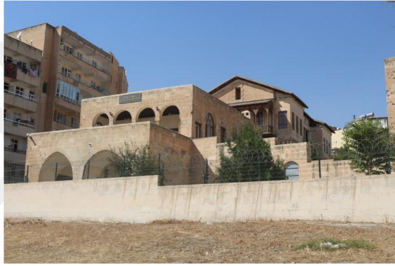
Şekil 5.41. Mahmut Nedim Kürkçüoğlu Konağı Genel Görünümü (Ağar, 2021)
