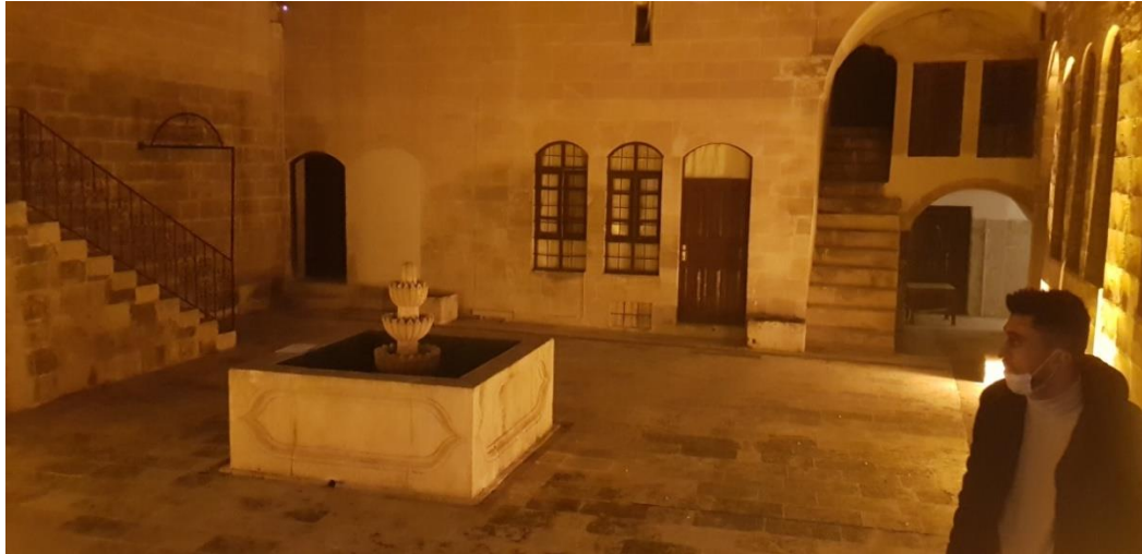
Şekil 4.69. Malatyalı Halil Evi Avludan Kuzey Cephe, ZK19 Avlu ve ZK-23 Dışarıdan Görünüş (Ağar, 2021)
