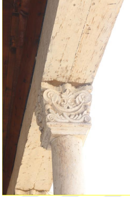
Şekil 5.55. Mahmut Nedim Kürkçüoğlu Konağı 2.Kat Balkonda Bulunan Sütun Başlığı Detayı(Ağar, 2021)
