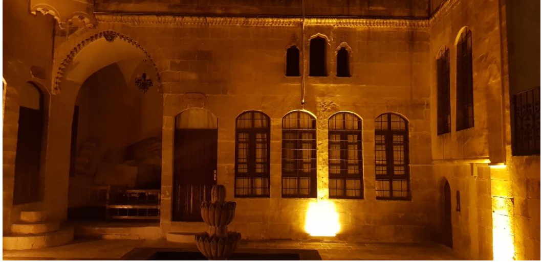
Şekil 4.70. Malatyalı Halil Evi Avludan Güney Cephe ve ZK-23 Dışarıdan Görünüş (Ağar, 2021)
