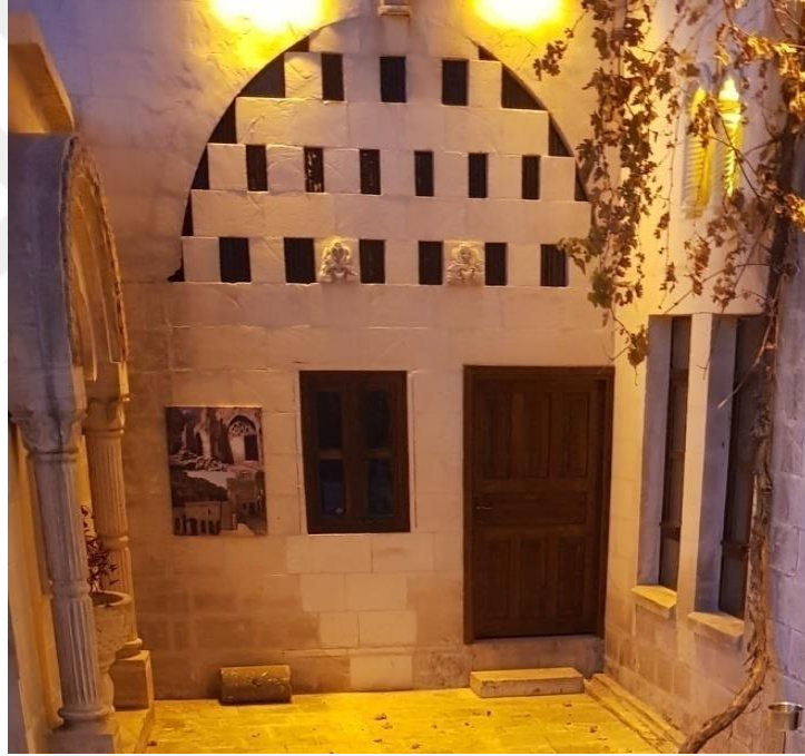
Şekil 4.90. Akçarlar Evi 1K-14 Mutfak Avludan Görünüm (Ağar, 2021)
