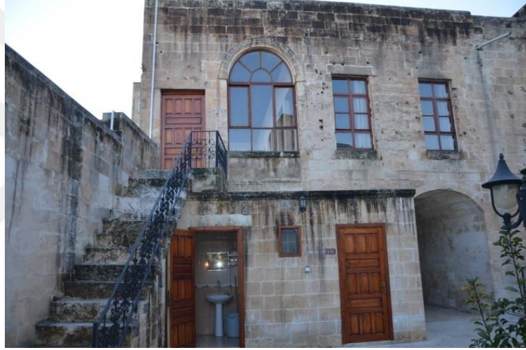
Şekil 5.81. B Blok Avludan Görünüş (Ağar, 2021)
