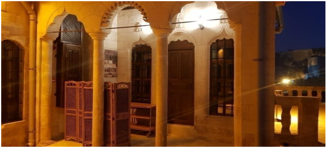
Şekil 4.94. Akçarlar Evi 2K-02 Revak ve 2K-01 Dışarıdan Görünüm (Ağar, 2021)
