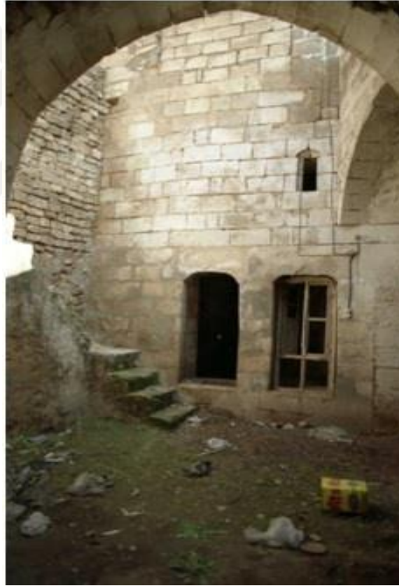
Şekil 4.77. Akçarlar Evi Selamlık Bölümü ZK-01 Onarım Öncesi (C.Kürkçüoğlu)
