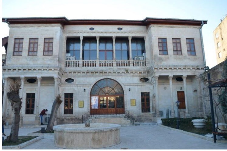
Şekil 5.83. C Blok Avludan Görünüş(Ağar, 2021)
