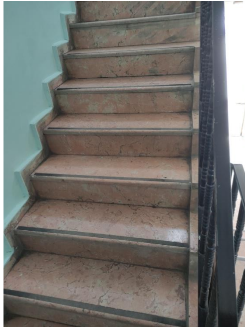
Şekil 7. İdari bina kat merdivenleri
