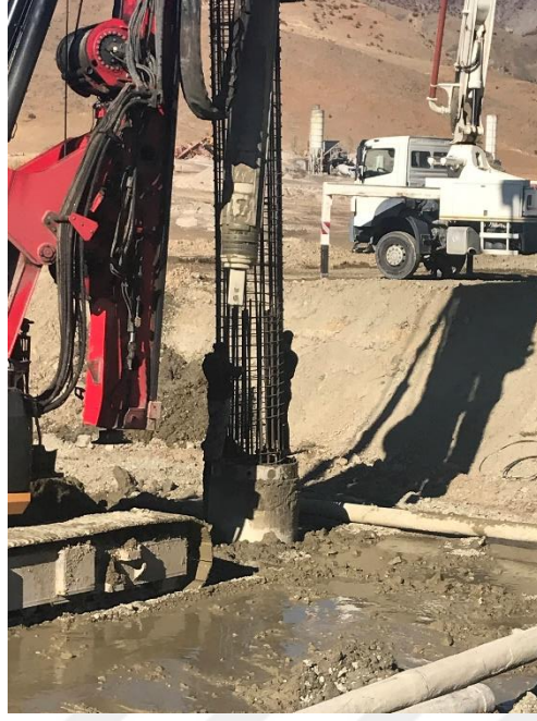
Şekil 25. Fore kazık çalışmaları
