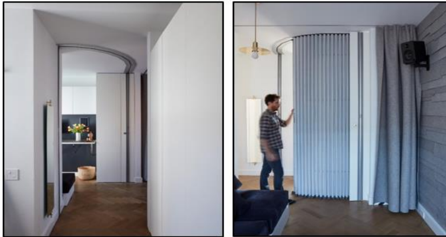
Şekil 4. 33. Açılıp Kapanabilen Bölme Duvar Kullanımı (Gibson, 2018)
