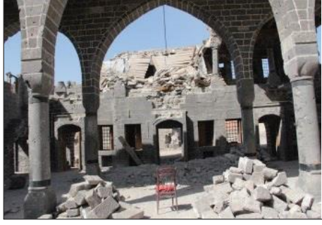
Şekil 3.35. Ermeni Katolik Kilisesinde çöken üst örtü ve kısmi duvar yıkılmaları (Işık, N., vd, 2017)
