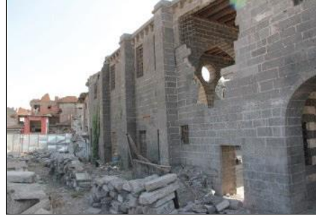
Şekil 3.35. Ermeni Katolik Kilisesinde çöken üst örtü ve kısmi duvar yıkılmaları (Işık, N., vd, 2017)
