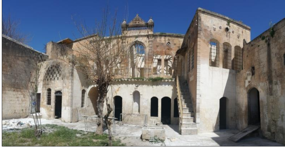
Şekil 3.10. Karazımeliler Evi kuzey cephesi (Demirkol, B., 2017)
