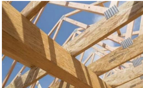
Şekil 2.39: LSL tabakalı şerit kerestenin ahşap karkas sistemde kiriş olarak kullanımı (URL-30)
