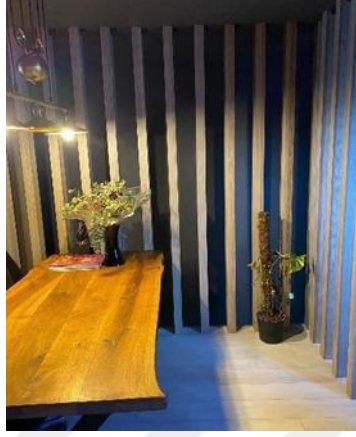
Şekil 3.5: Ahşap duvar kaplama örnekleri (2021)
