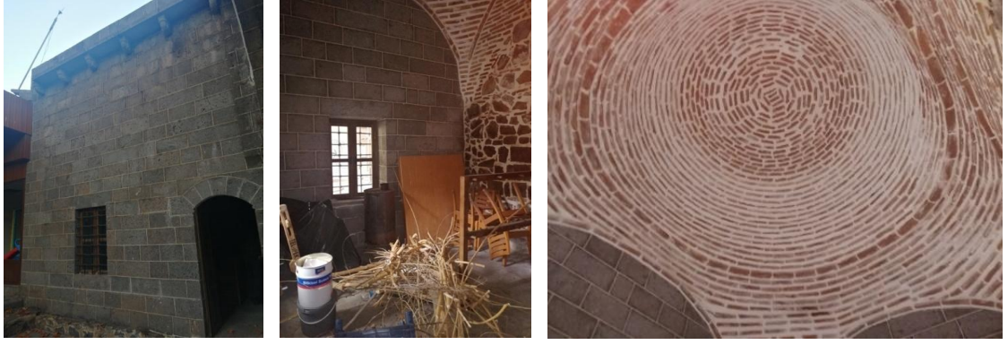
Şekil 6.61: (a) Birimin avlu cephesi, (b) Mekânın genel görünümü, (c) Mekânın üst örtüsü (Damar T. Fotoğraf Arşivi, 2020)
