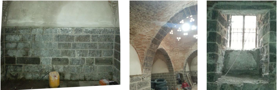
Şekil 4.10: Hamamda uygulanan taş, tuğla ve ahşap malzeme uygulamaları (DVBM, 2020)
