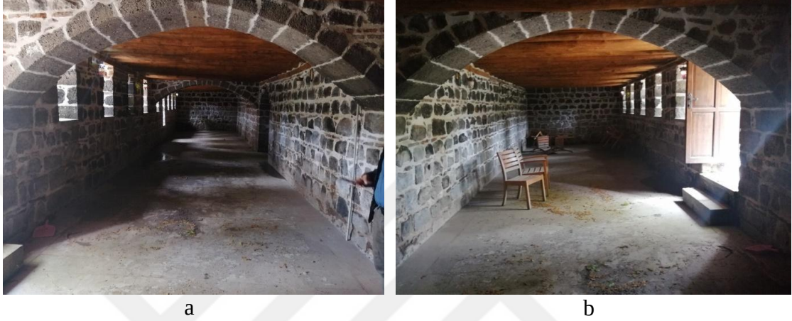
Şekil 6.60: (a) Bodrumun güney kanadı, (b) Bodrumun kuzey kanadı (Damar T. Fotoğraf Arşivi, 2020)
