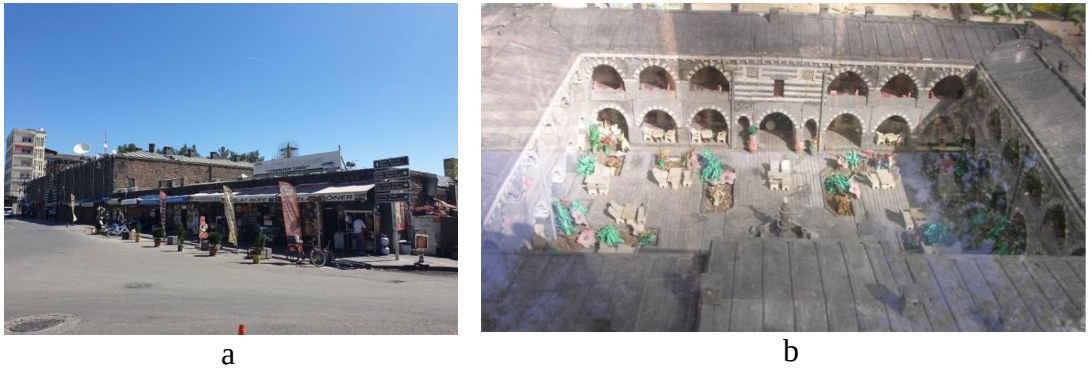
Şekil 5.3: (a) Han'ın giriş cephesi ve dükkânlar, (b) Han'ın avlusu ve revaklar (Damar T. Fotoğraf Arşivi, 2020; DVBM, 2020)
