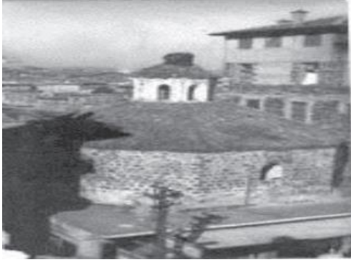
Şekil 4.8: Vahap Ağa Hamamı kubbe kasnağı ve aydınlık feneri (Kılıcı, 1970)
