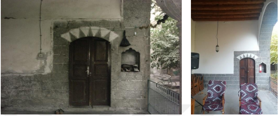
Şekil 6.47: Odanın giriş kapısının işlev değişikliği öncesi ve sonrası durumu (DVBM, 2020)
