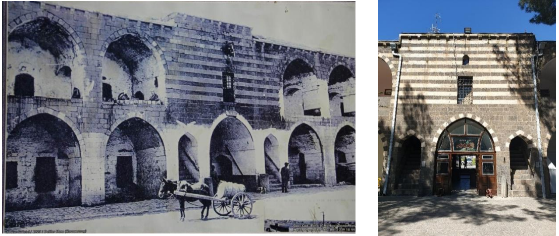
Şekil 5.75: Avlu doğu cephesi işlev değişikliği öncesi ve sonrası görünümü (Gabriel'den, 1933; Damar T. Fotoğraf Arşivi, 2020)
