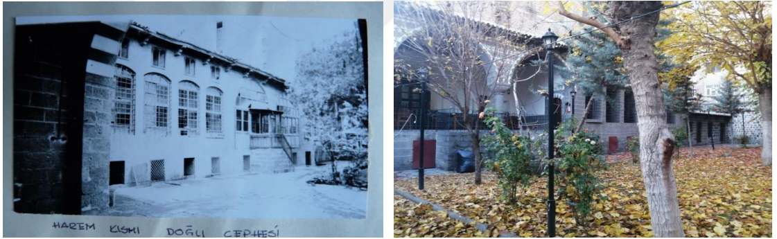
Şekil 6.77: Batı kanadının doğu cephesinin işlev değişikliği öncesi ve sonrası durumu (DVBM, 2020; Damar T. Fotoğraf Arşivi, 2020)
