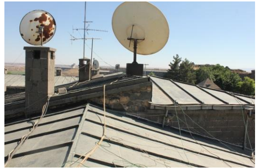
Şekil 5.67: Büyük kervansaray otel kurşun kaplamalı çatı örtüsü ve bacalar (DVBM, 2020)
