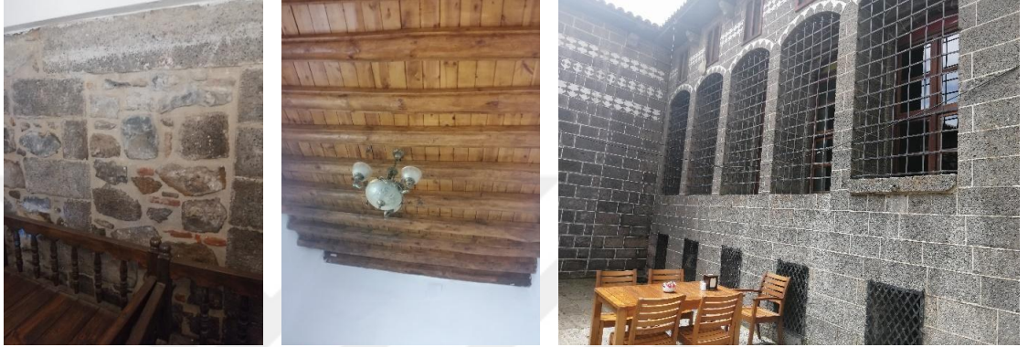
Şekil 6.22: İskender Paşa Konağı'nda kullanılan bazalt, ahşap ve demir malzeme örnekleri (Damar T. Fotoğraf Arşivi, 2020)
