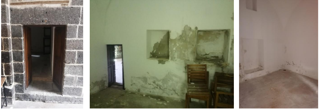
Şekil 6.41: 14 no’lu odanın giriş kapısı ve iç mekân görünümü (Damar T. Fotoğraf Arşivi, 2020)
