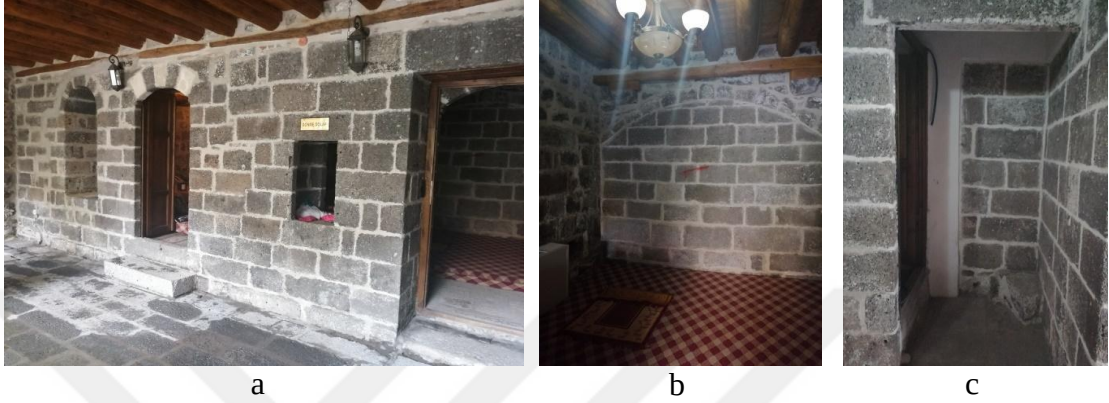
Şekil 6.58: Odaların avlu Cephesi, (a) Mescidin iç mekân genel görünümü, (c) Mescite ait wc'nin giriş holü (Damar T. Fotoğraf Arşivi, 2020)
