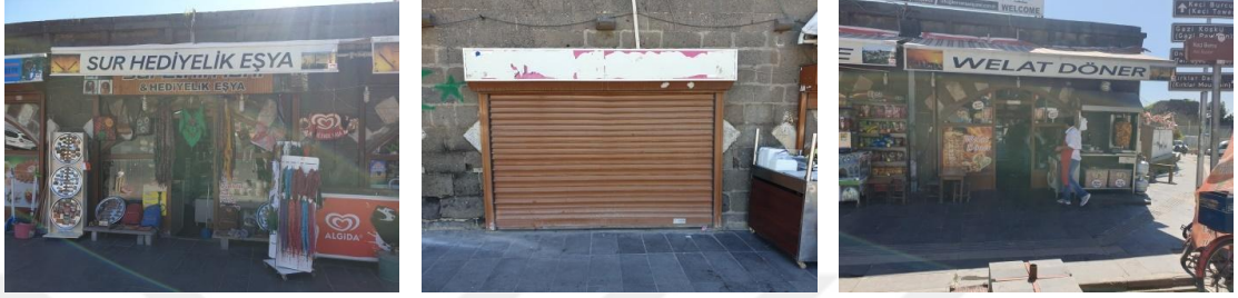
Şekil 5.26: Otelin batı cephesinde yer alan dükkânlar (Damar T. Fotoğraf Arşivi, 2020)
