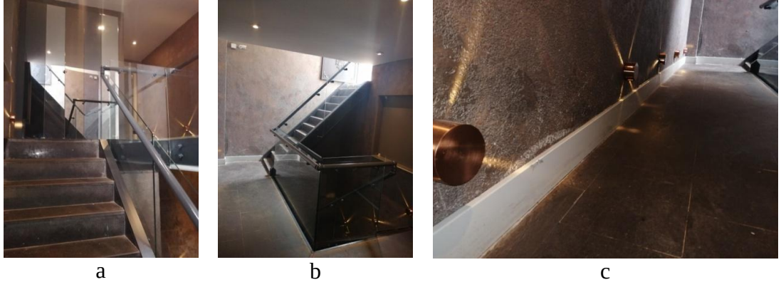
Şekil 4.35: (a) Restoranın kat merdiveni, (b) Birinci kat çatı çıkış merdiveni, (c) Duvar diplerine sabitlenmiş aydınlatma elemanları (Damar T. Fotoğraf Arşivi, 2020)
