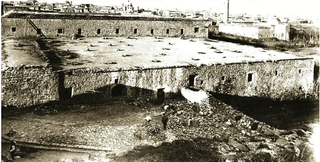
Şekil 5.10: Hüsrev Paşa (Deliller) Hanı güney cephesi (1954 öncesi) (DVBM, 2020)
