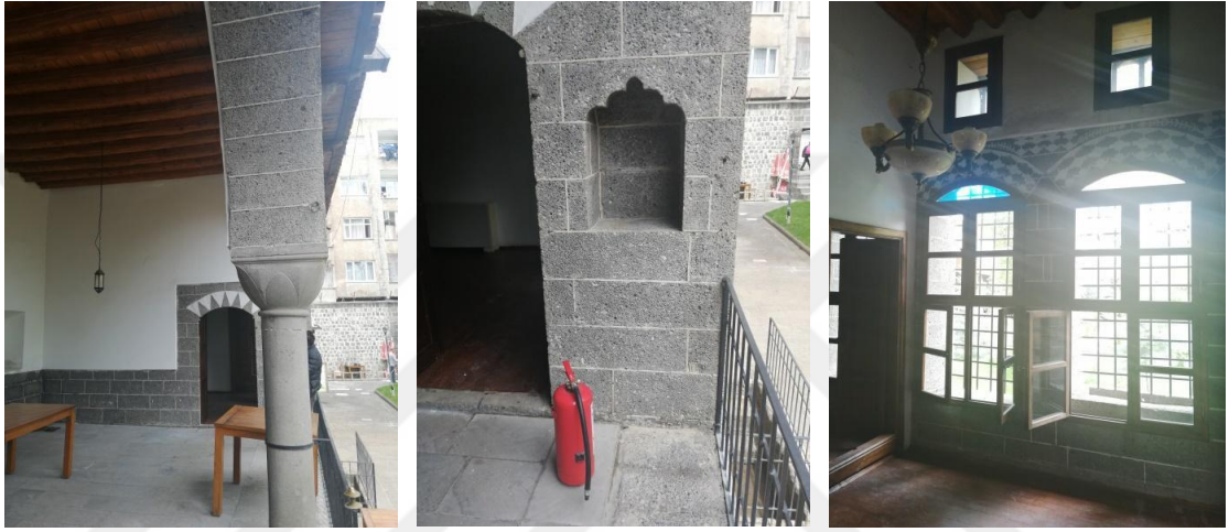
Şekil 6.5: (a) Eyvan tavanı, (b) Sofa girişi, (c) Eyvanın kuzey kanadında bulunan sofa (Damar T. Fotoğraf Arşivi, 2020)
