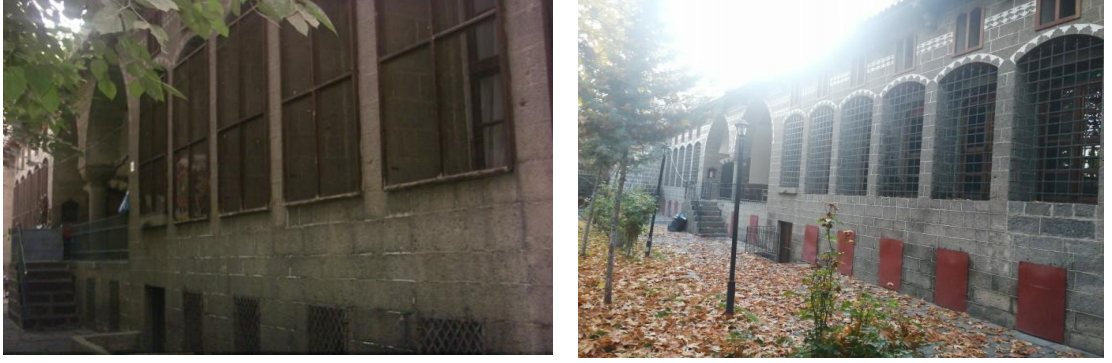
Şekil 6.76: Yapının batı kanadının işlev değişikliği öncesi ve sonrası görünümü (DVBM, 2020; Damar T. Fotoğraf Arşivi, 2020)
