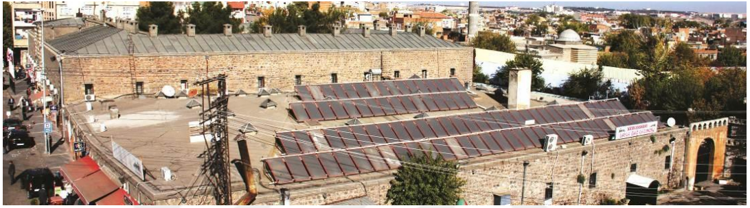
Şekil 5.9: Hüsrev Paşa (Deliller) Hanı güney cephesi (DVBM, 2020)
