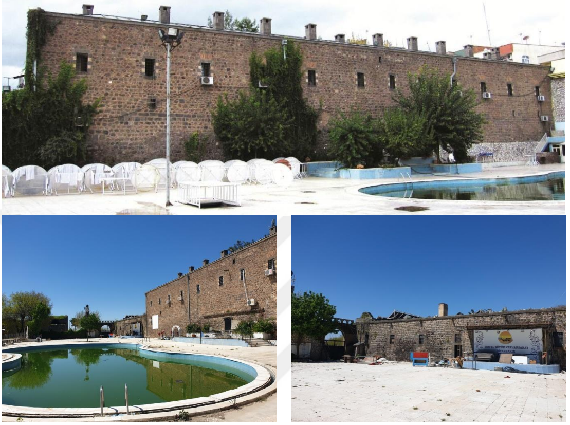
Şekil 5.11: Hüsrev Paşa (Deliller) Hanı doğu cephesi (DVBM, 2020)
