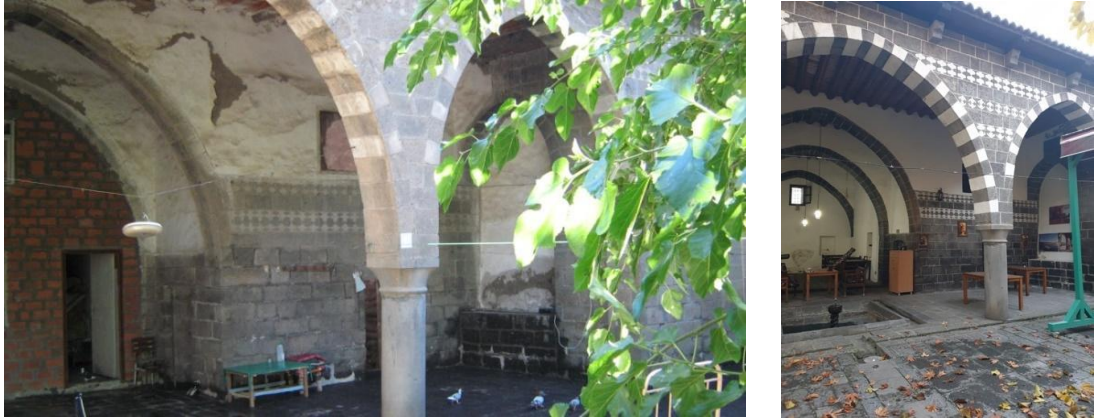
Şekil 6.29: Revak bölümünün işlev değişikliği öncesi ve sonrası görünümü (DVBM, 2020; Damar T. Fotoğraf Arşivi, 2020)
