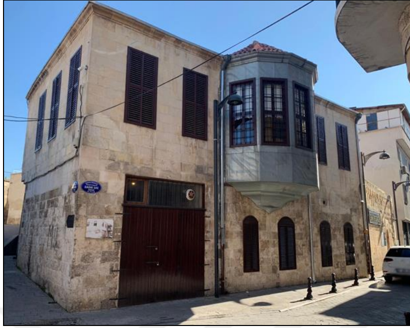
Şekil 3.9 Sokak Cephesi Restorasyon Sonrası (Emine Göğüş Mutfak Müzesi, 2022, Kaynak: Yazar)
