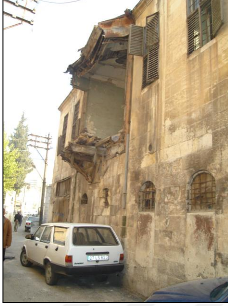
Şekil 3.7 Emine Göğüş Mutfak Müzesi Restorasyon Öncesi Batı Cephesi (Gaziantep KUDEB, 2008)
