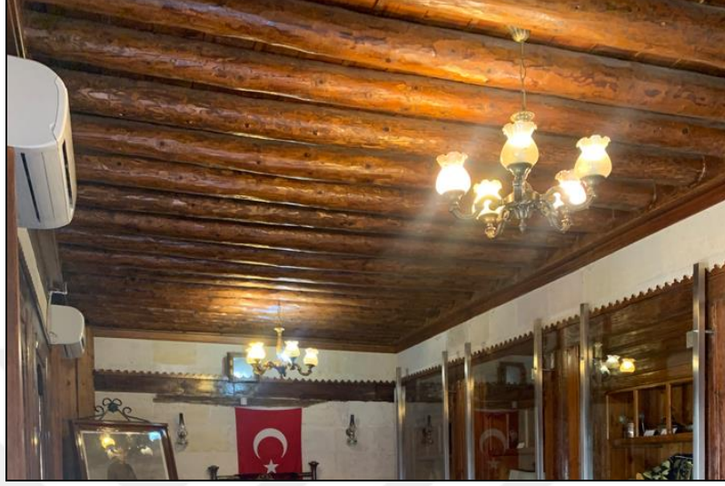
Şekil 2.11 Ahşap Kirişli Tavan Örneği (Atatürk Anı Müzesi, 2021, Kaynak: Yazar)
