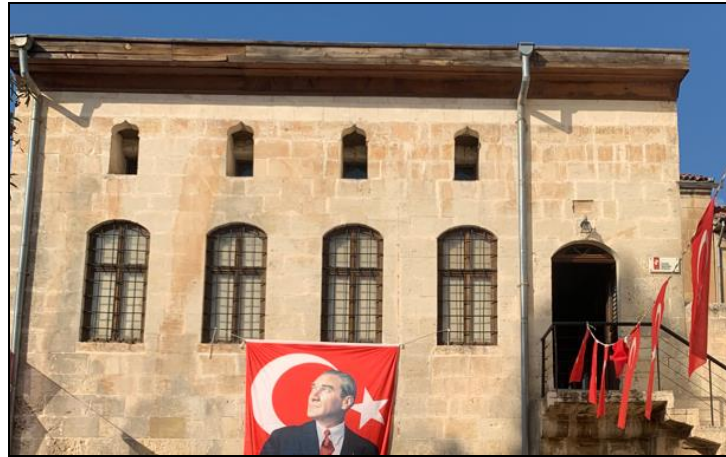
Şekil 2.14 Kuş Pencereleri Örneği (Atatürk Anı Müzesi, 2021, Kaynak: Yazar)
