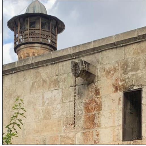
Şekil 2.15 Çörten Örneği (Ömeriye Cami, 2021, Kaynak: Yazar)
