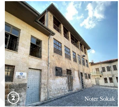
Şekil 5.21. 10 pafta 1072 ada 42 parselde yer alan yapının fotoğrafları
