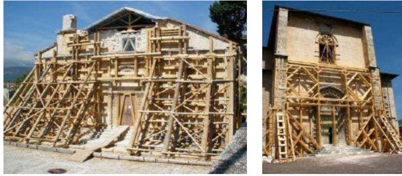
Şekil 3. 3. Santa Giusta Kilisesi'nin ve San Domenico Kilisesi'nin ön cephe duvarına uygulanmış olan acil yapı desteği örneği (Claudio ve diğerleri, 2010)
