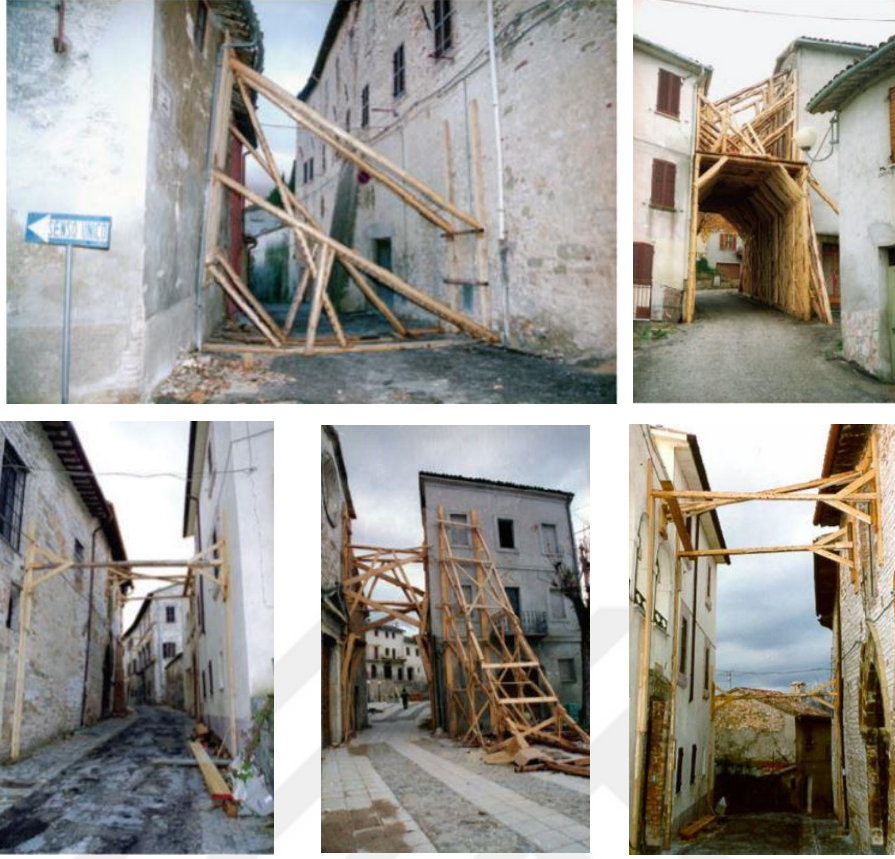
Şekil 3. 4. 1997 İtalya Marche Depremi sonrası uygulanmış olan yanlış yapı desteği örneği (Goretti, 2006) (Ministry of Interior Italian Fire Service, 2010)
