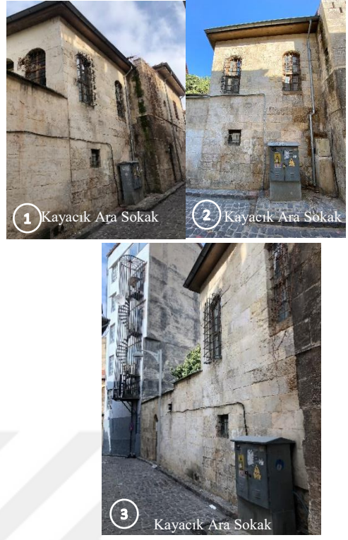
Şekil 5.57. 10 pafta 1071 ada 12 parselde yer alan yapının fotoğrafları
