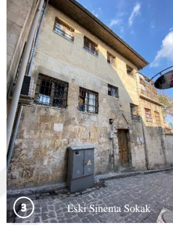
Şekil 5.77. 10 pafta 1072 ada 5 parselde yer alan yapının fotoğrafları
