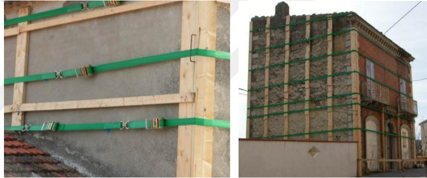
Şekil 3. 10. 2002 Molise Depremi sonrası yapının bantlarla sarılması örneđi (Goretti, 2006)
