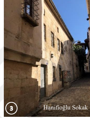
Şekil 5.49. 10 pafta 1073 ada 15 parselde yer alan yapının fotoğrafları
