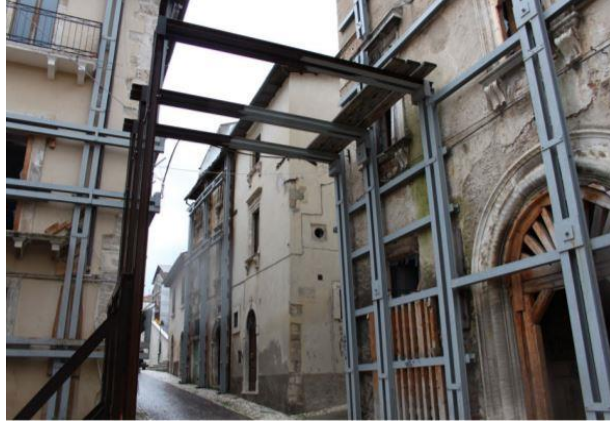
Şekil 3. 13. 2009 L'Aquila Depremi sonrası yapılara uygulanmış olan çerçeve destek örneği (Rossetto ve diğerleri, 2014)
