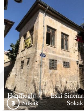
Şekil 5.5. 10 pafta 1072 ada 7 parselde yer alan yapının fotoğrafları
