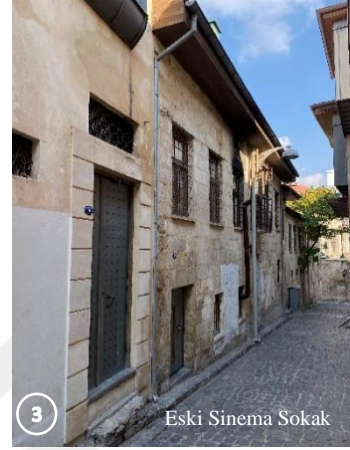
Şekil 5.73. 10 pafta 1072 ada 37 parselde yer alan yapının fotoğrafları
