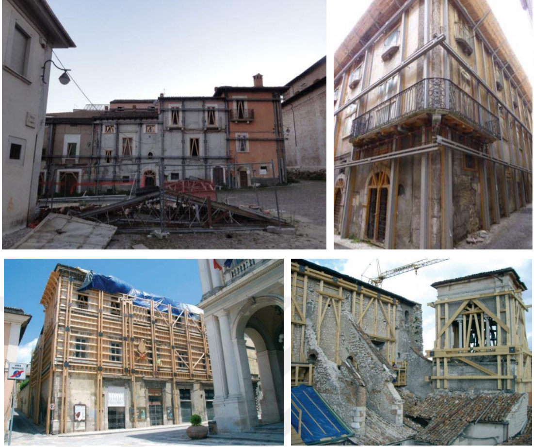
Şekil 3. 12. 2009 L'Aquila Depremi sonrası yapının kısmen ya da tamamen çerçevelerle sarılması örneği (Rossetto ve diğerleri, 2014) (Grimaz, 2011)
