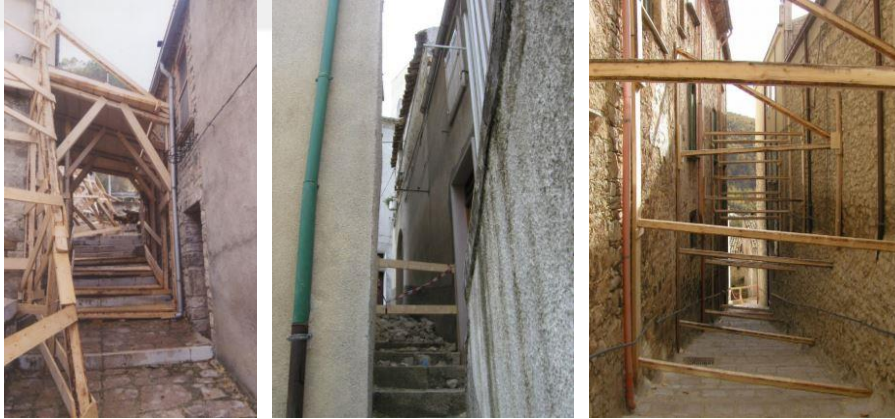
Şekil 3. 4. 1997 İtalya Marche Depremi sonrası uygulanmış olan yanlış yapı desteği örneği (Goretti, 2006) (Ministry of Interior Italian Fire Service, 2010)
