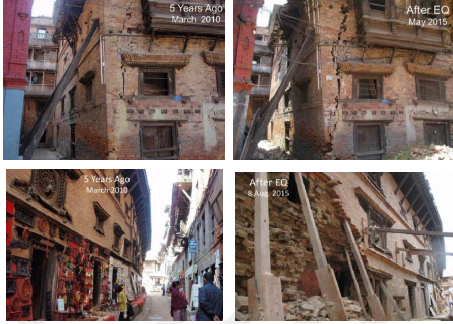
Şekil 3. 7. 2015 Nepal Depremi sonrası uygulanmış olan yanlış yapı desteği örneği (Mannella ve diğerleri, 2016)
