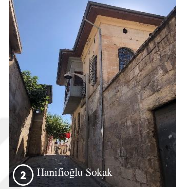
Şekil 5.11. 10 pafta 1074 ada 54 parselde yer alan yapının fotoğrafları
