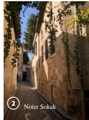
Şekil 5.29. 10 pafta 1073 ada 10 parselde yer alan yapının fotoğrafları
